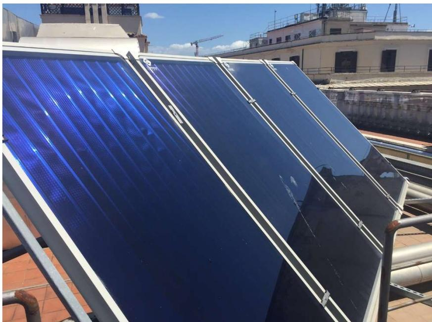
*Figura 67. Impianto solare termico per la produzione di ACS*
