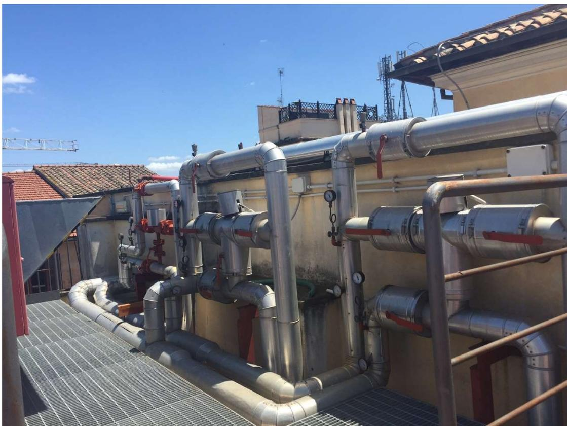
*Figura 64. Pompe e valvole di regolazione della centrale frigorifera*
