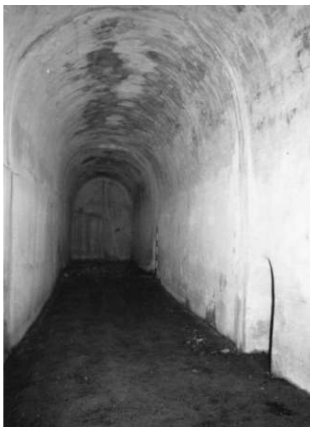
Fig. 27. Navata della cisterna della villa (c.d. “villa della Triade Capitolina”) nel Quarto del Campanile all’Inviolatella (da Z. MARI, Tibur, pars tertia , “Forma Italiae” I, 17, Firenze 1983) [n. 28]
