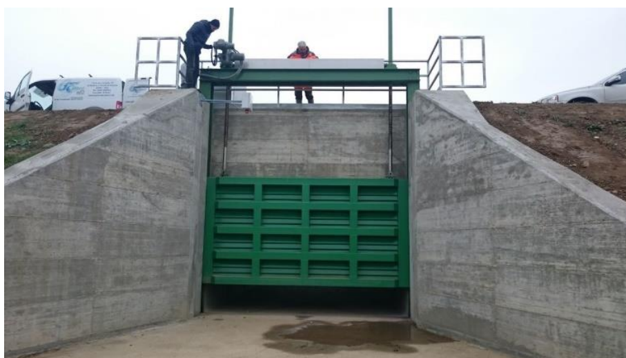
Figura 15 – Paratoia gestita da un sistema di movimentazione meccanica
