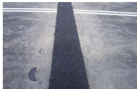
Figura 3-9: Giunto tampone
