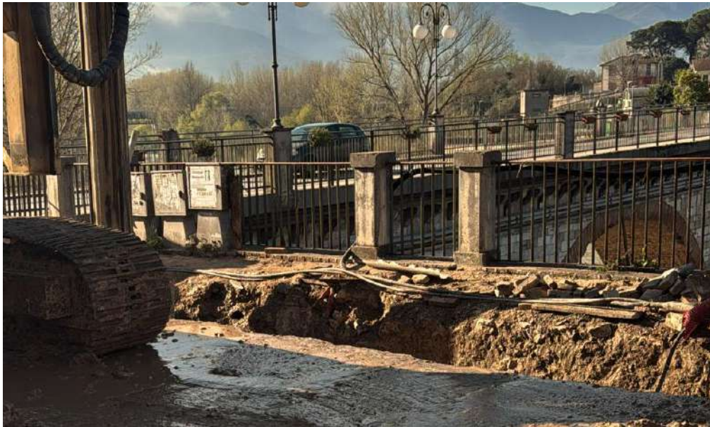
Figura -1: Parapetto esistente
