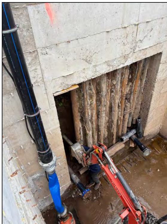
FOTO 3 – Postazione del prelievo a parete (lato via Carlo Levi)
