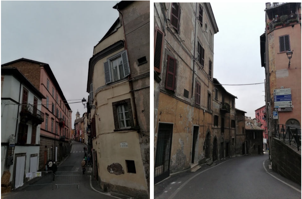
Quadrivio, veduta verso est e verso via Cavour.
