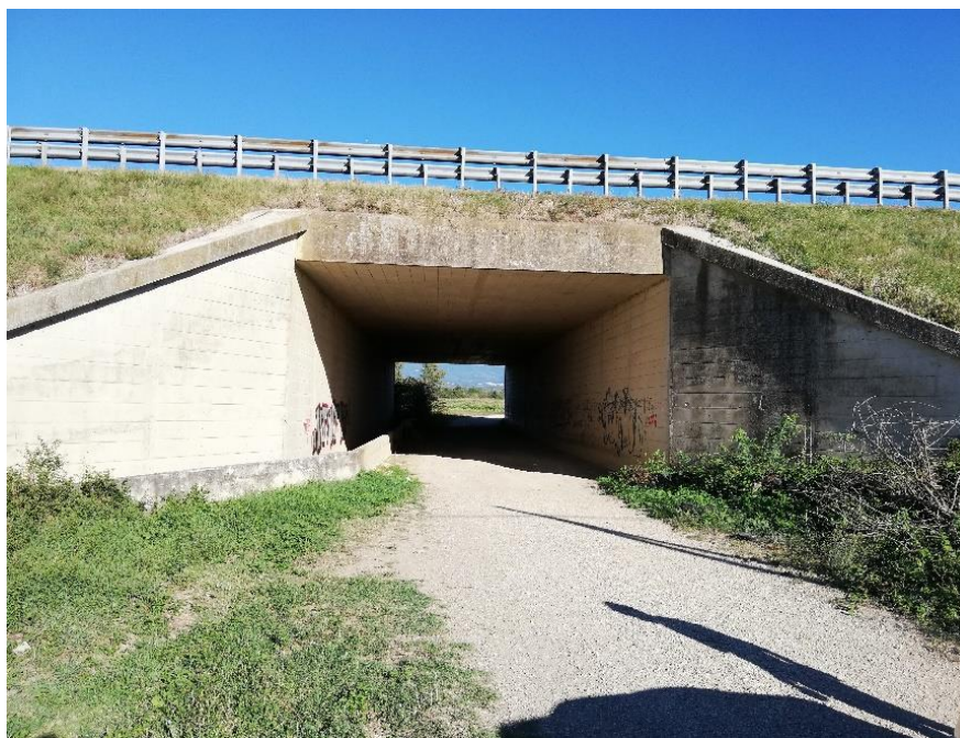
Figura 31: Sottopasso autostradale T1
