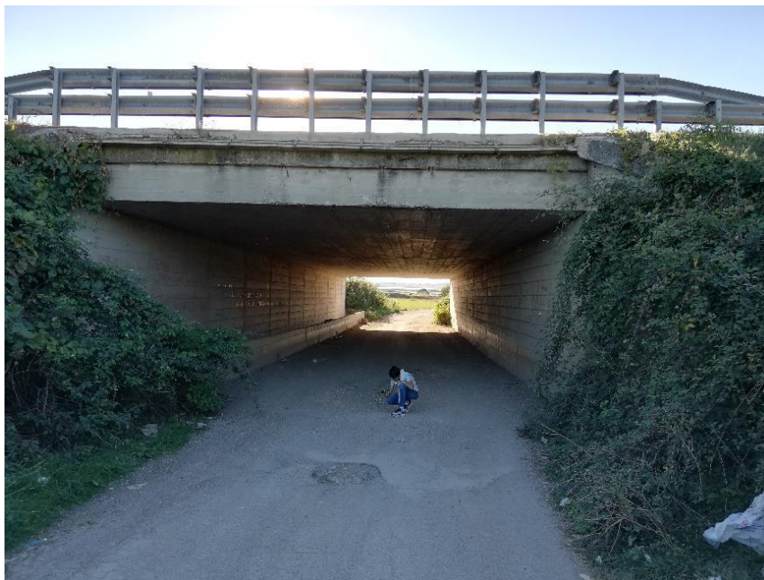
Figura 32: Sottopasso autostradale T2
