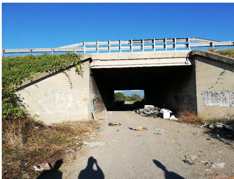
Figura 33: Sottopasso autostradale T3
