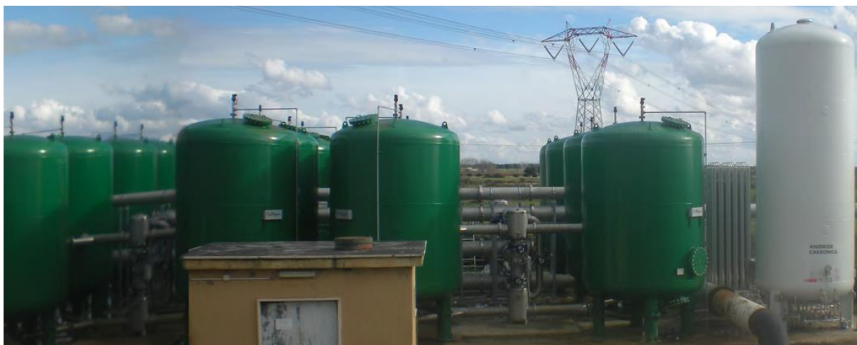
Impianto acquedotto Carano-Giannottola
