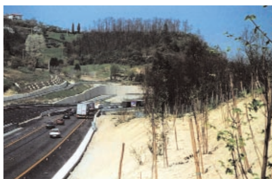
Foto 18.23 - Messa a dimora di specie arbustive ed altoarbustive autoctone su rilevato in trincea su litologia a matrice argillosa. 3a corsia Autostrada Orte-Fiano. Foto G. Sauli
