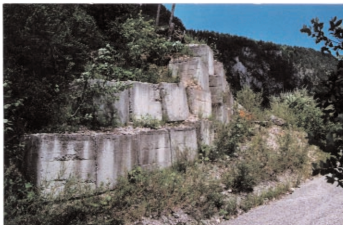
Strada accesso imbocco 4 Ferrovia Pontebbana, (UD) ante operam
