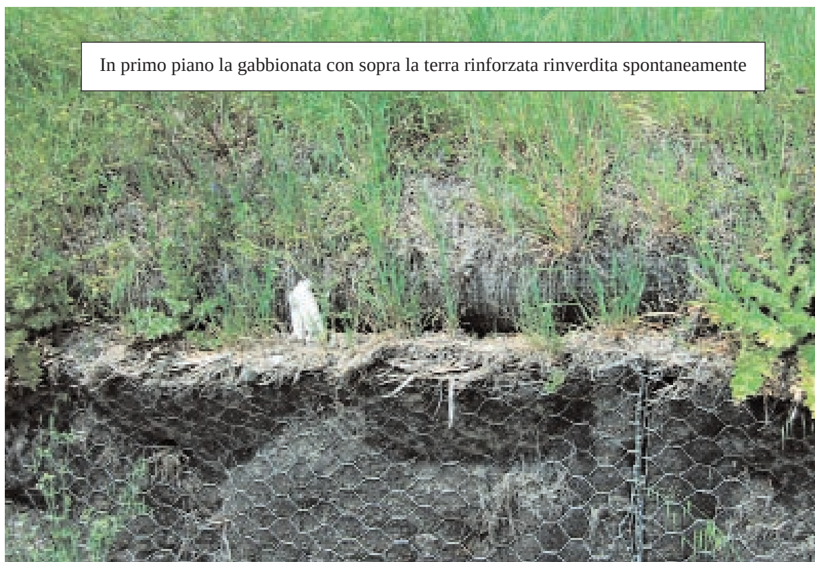
Particolare del gabbione e della terra rinforzata superiore
