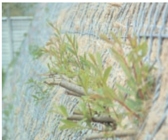
Foto 18.66 - Particolare talee su campione barriera antirumore in terrapieno in doppia terra rinforzata verde. Casalecchio - Foto G. Sauli
