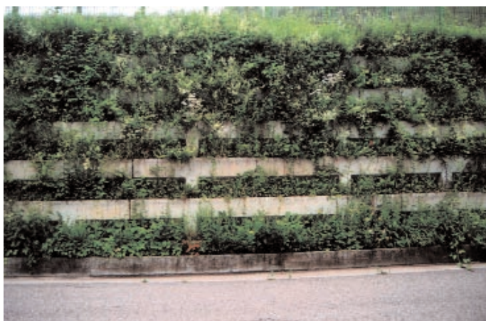
Muro cellulare rinverdito Tarvisio Boscoverde (UD), giugno 2003
