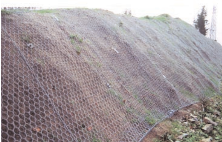
Scarpata in roccia arenacea a 45° con rivestimento vegetativo e stuoia organica; Foto G. Sauli Stazione FS, Tarvisio-Boscoverde (UD), 2000
