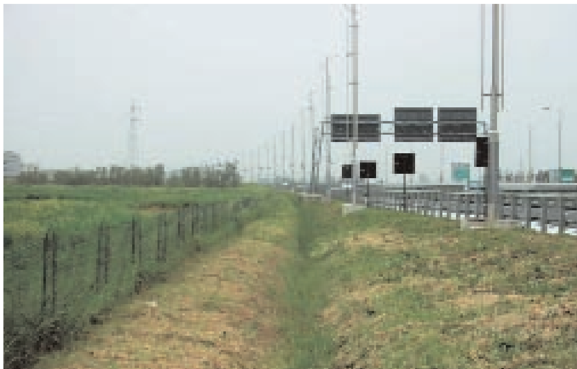
Vista del fosso a manutenzione effettuata aprile 2002
