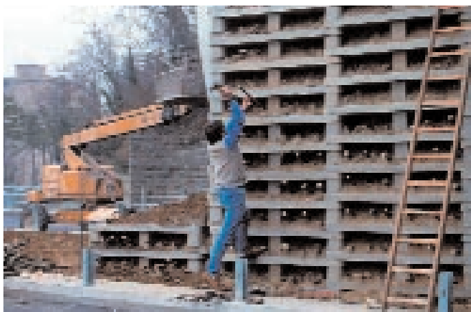
Piantagione di talee in crib-wall, galleria di Servola (TS)
