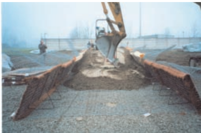
Barriera vegetativa antirumore in doppia terra rinforzata, fase di costruzione
