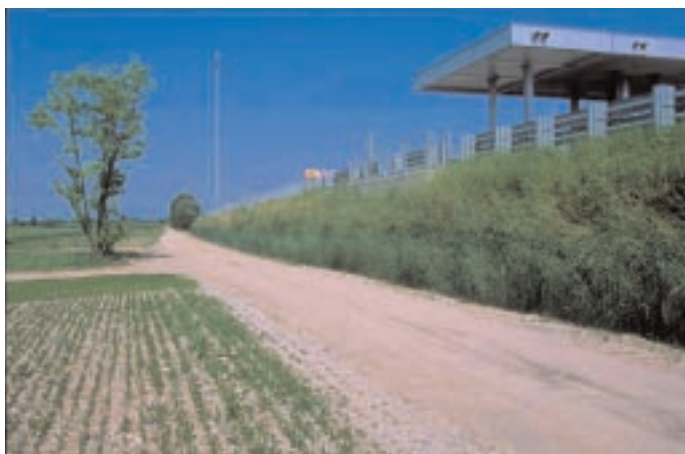
Terra rinforzata su scarpata autostradale Casello di Villesse (GO)
