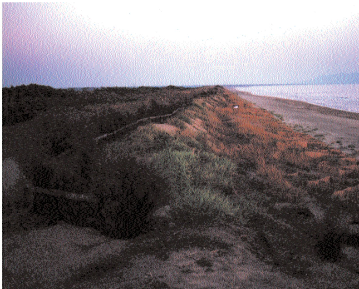
Foto 19.2.6 - Schermi frangivento disposti a scacchiera a due anni dalla realizzazione
