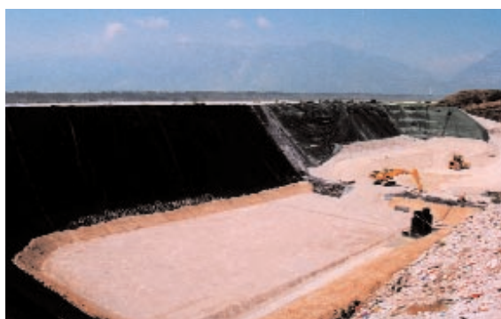
Foto 17.5 – Discarica di Maniago (PN) Loc. Cossana. Preparazione del fondo di discarica a fossa. Foto: G. Sauli - 2002
