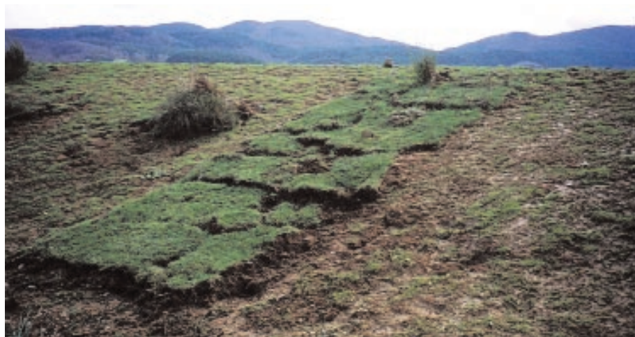
Trapianto di zolle erbose su argini in terra per evitare la sommersione di habitat rari Bacino di invaso della Diga di Alaco (CZ), giugno 2003
