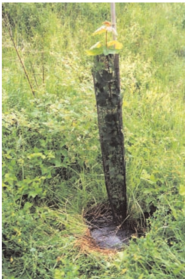
Messa a dimora di arbusti autoctoni con rete antifauna e disco pacciamante, Tarvisio Ponte ad Arco (UD)
