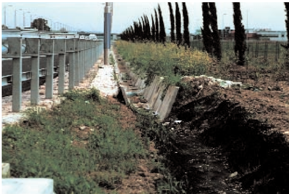
Lavori in corso giugno 2000 foto Polverino
