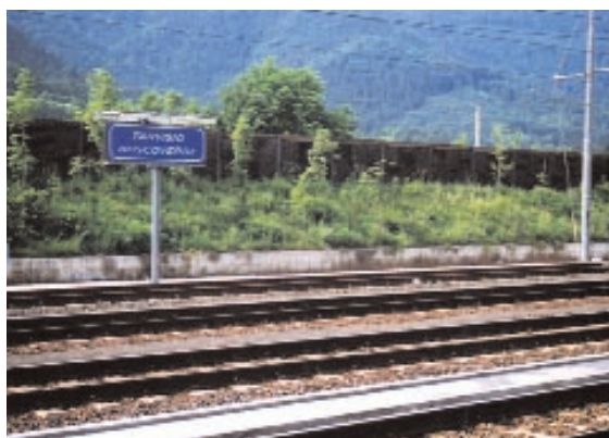
Foto 18.72 - Pannelli fonoisolanti su terrapieno arbustato. Stazione ferroviaria di Tarvisio Boscoverde (UD). Foto G. Sauli
