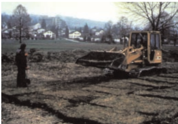
Espianto di zolle erbose su tracciato stradale (CH)
