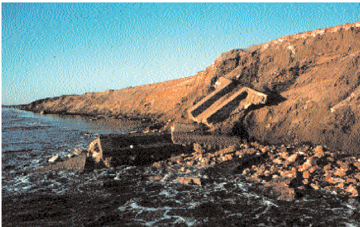
Foto 19.2.2 - Gli effetti delle mareggiate degli anni '80: demolizione parziale della duna e della strada costiera
