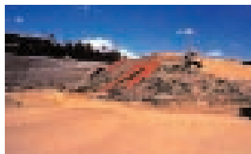
Foto 17.2 - Fase di ricoprimento con terreno vegetale del I° lotto. Discarica di RSU di Sciaves (BZ) Foto: G. Sauli
