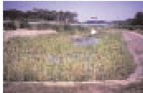
Foto 18.79 - Ecosistema filtro con vegetazione palustre, con funzione di vasca stradale di prima pioggia. Autostrada Parigi-Lione (Francia). Foto G. Sauli
