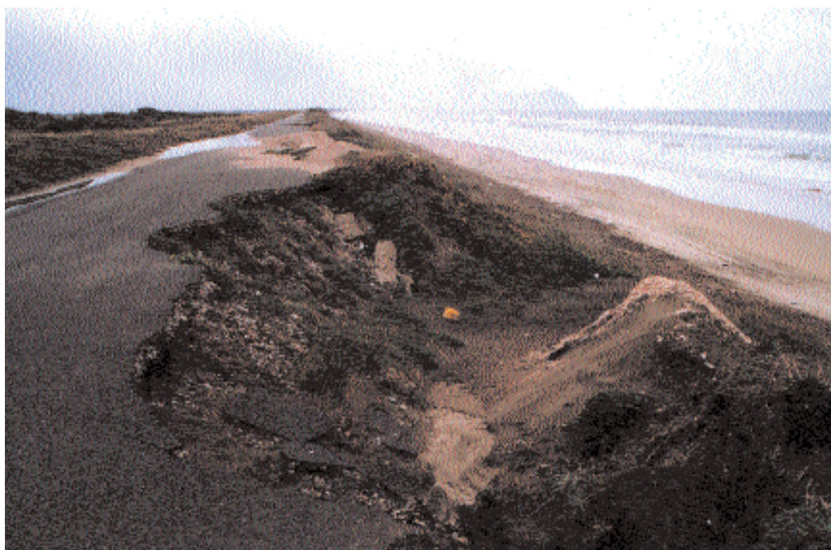
Foto 19.2.7 - Nicchia di erosione prodotta dalle acque di ruscellamento con effetti sovrapposti del calpestio e della erosione eolica
