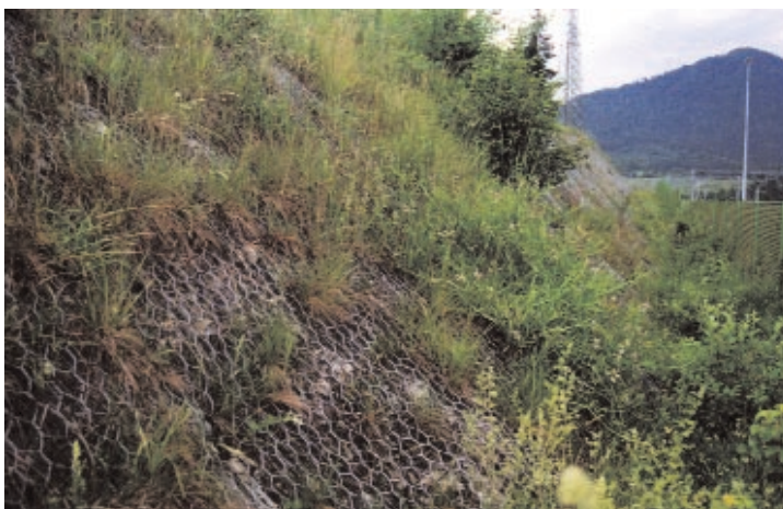
Rivestimento vegetativo in rete metallica Foto G. Sauli e stuoia organica, Stazione FS, Tarvisio-Boscoverde (UD), giugno 2003
