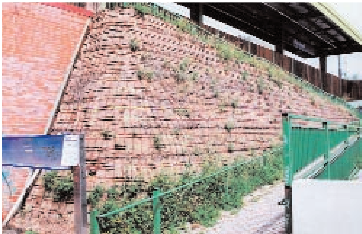
Terra rinforzata di sostegno del rilevato ferroviario
