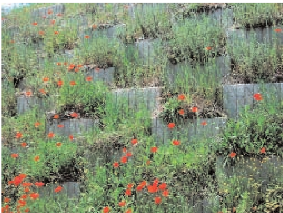
Primo piano degli elementi scatolari con rinverdimento spontaneo
