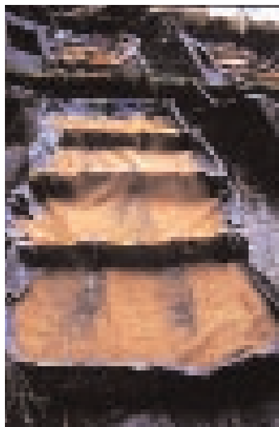
Rivestimento di rocce arenacee Foto G. Sauli con materassi verdi, diga di Ridracoli, (FO), 1997
