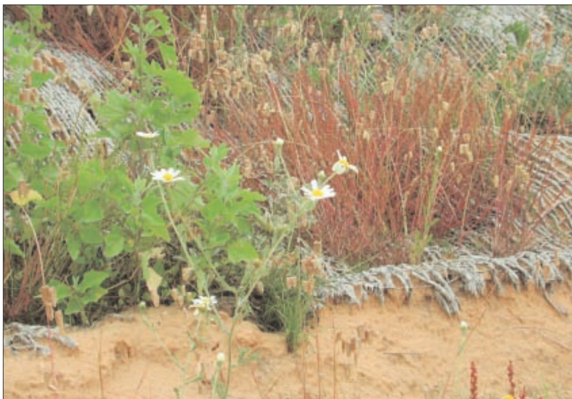
Foto 4c - Particolare: rete in geostuoia ed essenze erbacee
