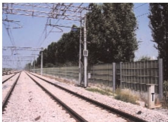
Foto 18.73 - Pannelli fonoassorbenti abbinati a fascia boscata tampone. Scalo ferroviario di Cervignano UD). Foto G. Sauli
