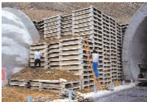
Foto 18.14 - Rivegetazione rilevati e crib-wall. Galleria di Servola. Grande viabilità triestina (TS). Foto G. Sauli - 1987
