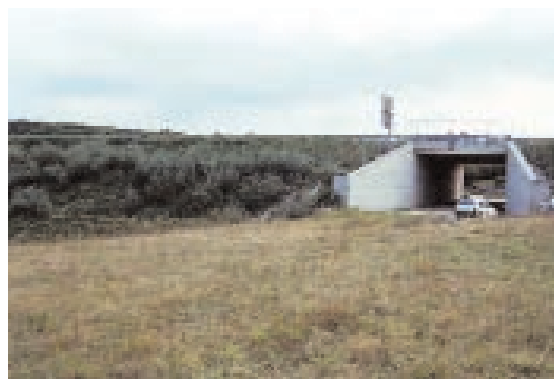
Foto 18.85 - Sottopasso scatolare per macrofauna. Grande viabilità Trieste. Zona Slivia. Foto G. Sauli
