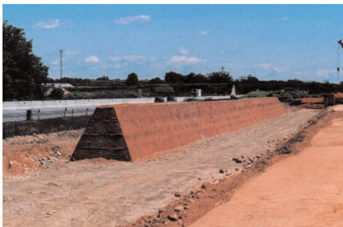
Barriera vegetativa antirumore in doppia terra rinforzata
