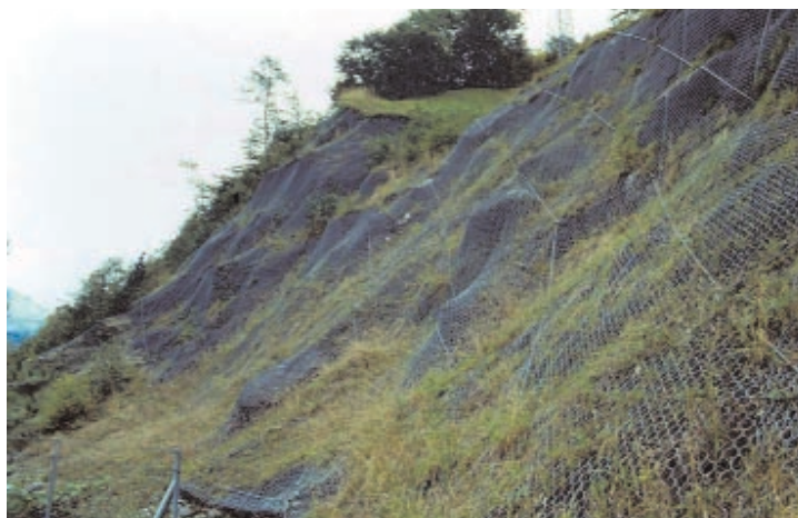
Particolare rivestimento vegetativo in rete metallica a doppia torsione e geostuoia tridimensionale Galleria Pontebba (UD), Autostrada A23, 1987
