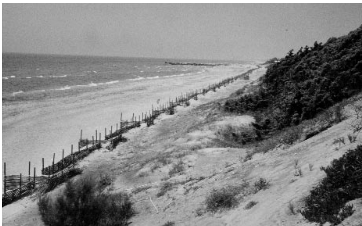
Foto 19.1.1 - Sabaudia (LT), Parco Nazionale del Circeo. Lavori di fissazione delle dune (foto S. Puglisi)
