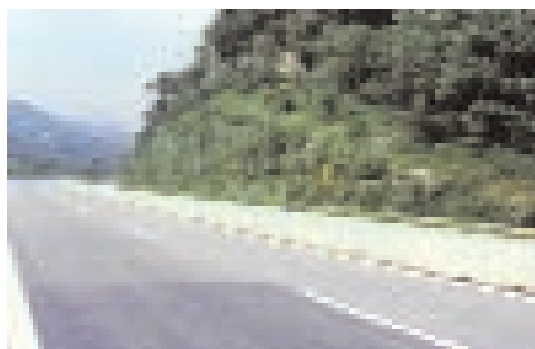
Foto 18.48 - Muro verde in terra armata rinverdito. Autostrada de Trafori Loc. Inverio. Foto G. Sauli - 1998
