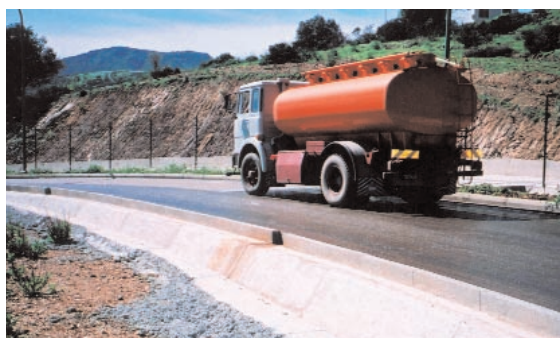
Foto 17.16 – Spargimento d'acqua lungo le strade interne della discarica, Gennaluas (CA). Foto: G. Sauli
