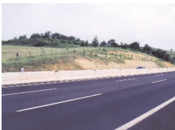
Foto 18.40 - Esempio di scarpata in trincea con piantagioni su berma intermedia, che sottolineano il "geometrismo" morfologico. Raccordo Roma nord. Foto G. Sauli
