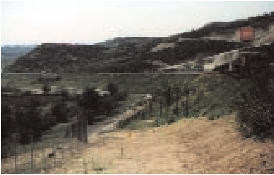
Foto 18.8 - Scarpata in rilevato, rinverdata 3a corsia Autostrada Orte-Fiano Settembre 2002 - Foto G. Sauli.
