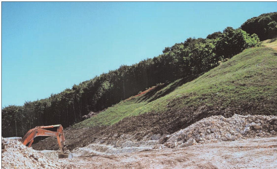
Foto 9d - Cantiere estrattivo in laavorazione; si nota a monte la scarpata finale già rinverdita, al centro i microgradoni riempiti in attesa degli impianti vegetali, in basso il piazzale di cava ed i microgradoni in corso di realizzazione con l'escavatore
