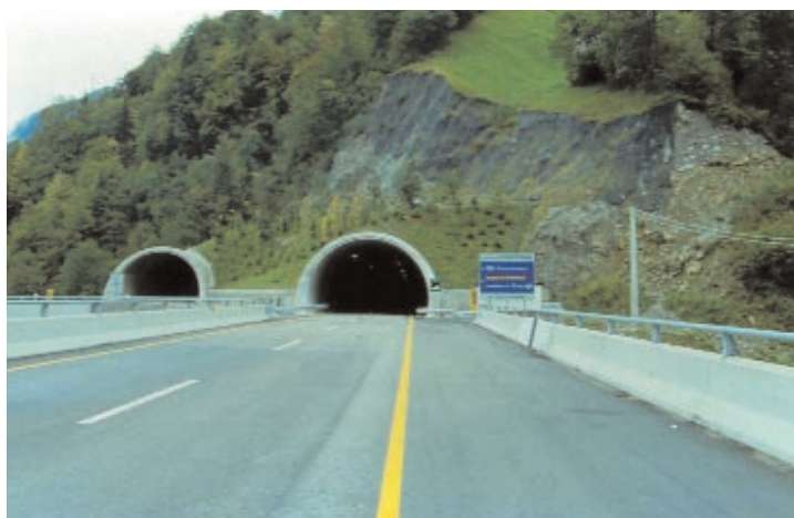
Rivestimento vegetativo in rete metallica a doppia torsione e geostuoia tridimensionale Galleria Pontebba (UD), Autostrada A23, 1987
