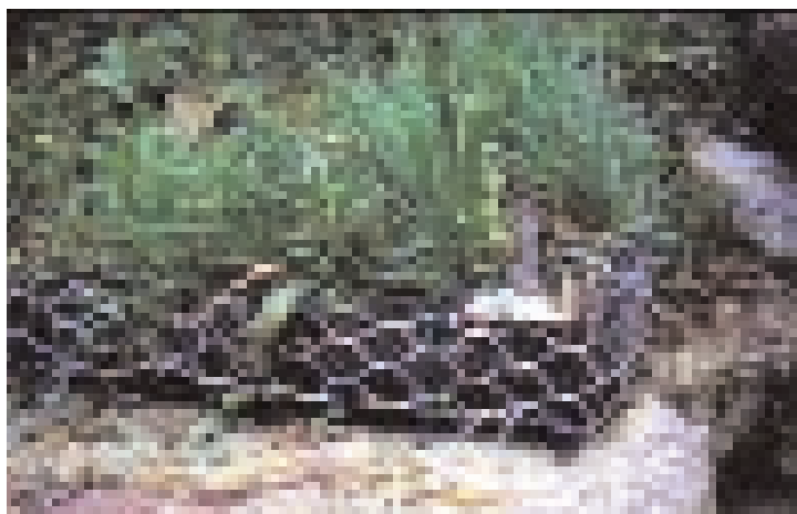
Rivestimento di rocce arenacee con materassi verdi, Diga di Ridracoli, (FO), 1997
