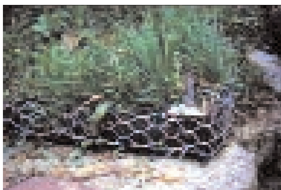
Foto 16.46 - Rivegetazione versanti rocciosi, diga di Ridracoli, materasso verde Foto: G. Sauli
