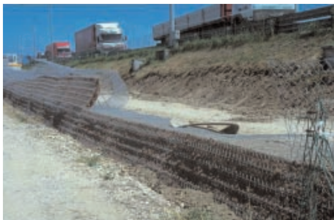
Terra rinforzata su scarpata autostradale in fase di costruzione, Casello di Villesse (GO)
