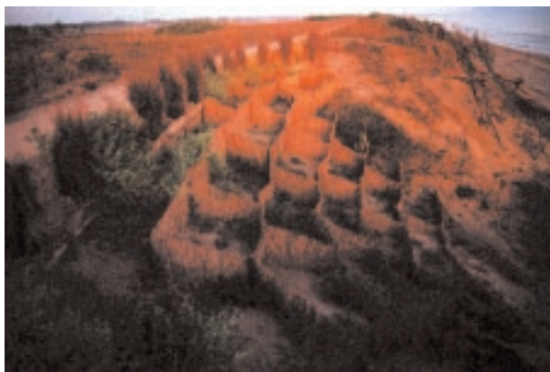
Foto 19.2.8 e 19.2.9 - Sistemazione delle nicchie di erosione mediante consolidamento combinato
