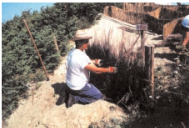
Foto 19.2.10 e 19.2.11 - Fasi della realizzazione del consolidamento combinato
