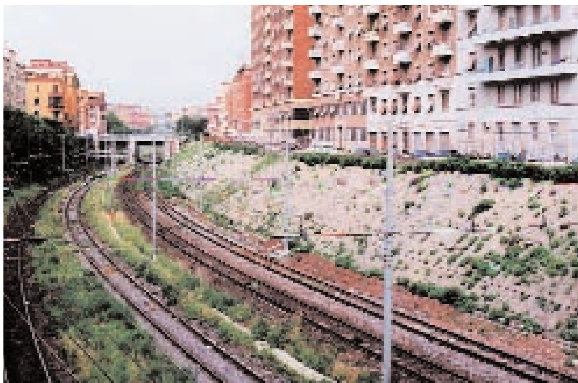
Vista d'insieme della scarpata ferroviaria
