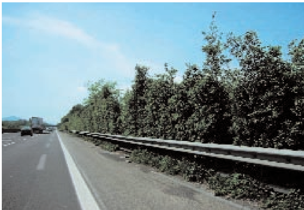
Vista anteriore della struttura con esemplari di Quercus ilex
