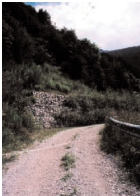
Sostituzione di muro in CLS con gabbionate rinverdite su strada accesso ferrovia pontebbana Moggio Udinese (UD) 2002
