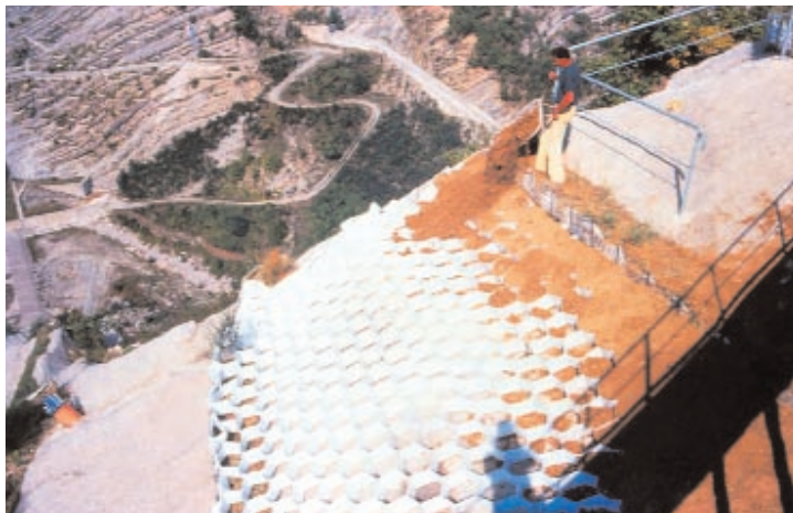
Campione di prova geocelle a nido d'ape Diga di Ridracoli (FO) 1992
