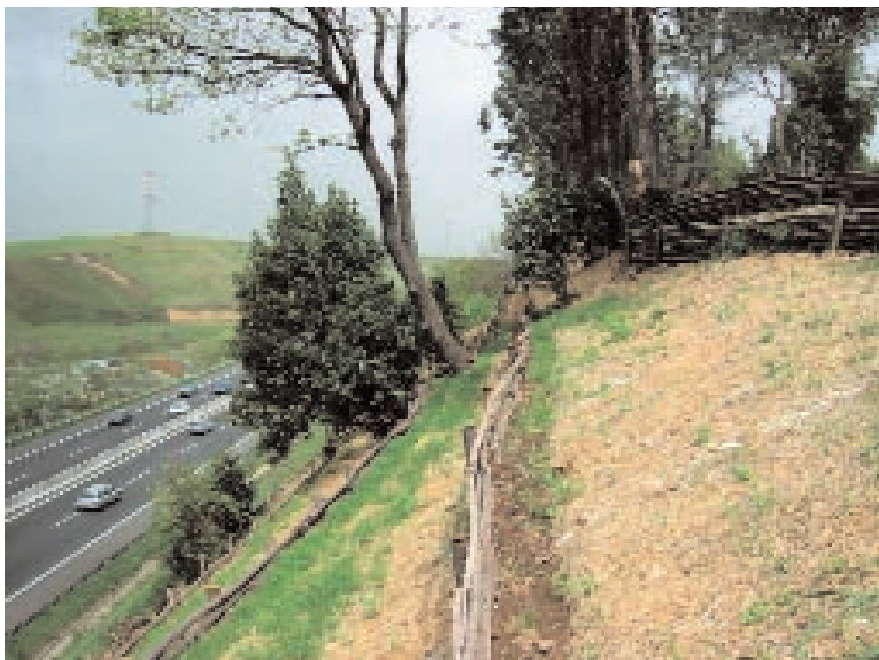
Particolare della biostuoia e della viminata morta
