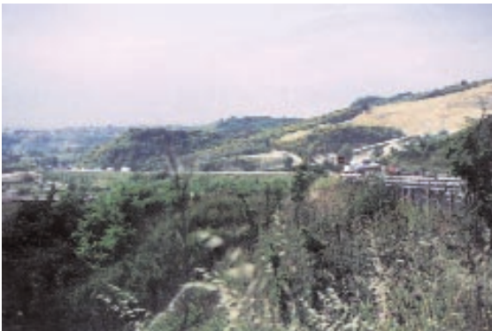
Foto 18.9 - Scarpata in rilevato, a crescita avvenuta 3a corsia Autostrada Orte-Fiano. Maggio 2003 - Foto G. Sauli.
