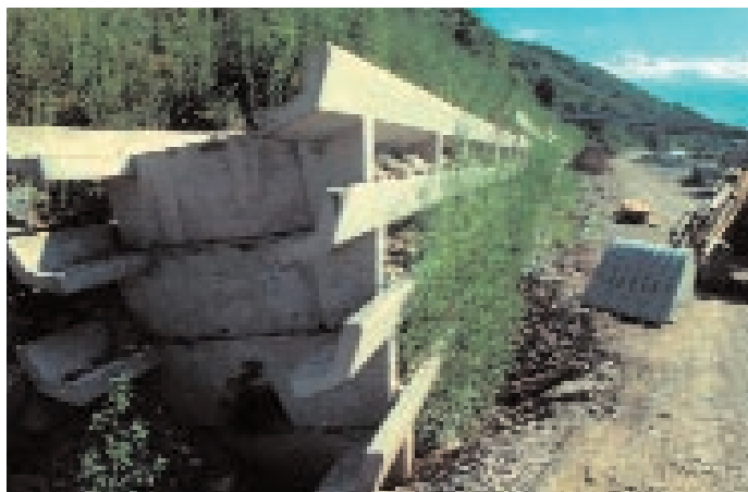
Muro cellulare rinverdito, fase di costruzione Inverio (NO), luglio 1991
