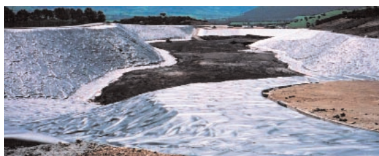
Foto 17.15 - Preparazione della sigillatura di fondo della discarica di fanghi industriali di Gennaluas (CA), su un rimodellamento morfologico della vecchia miniera di pirite. Foto: G. Sauli
