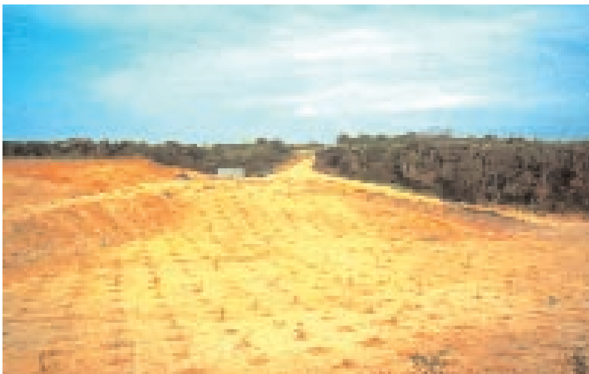
L'area alla fine dei lavori di recupero ambientale (1988)
