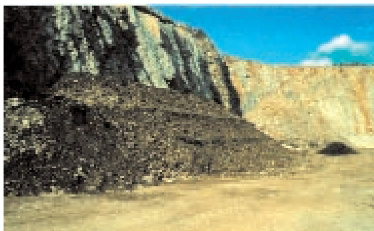
Foto 16.15 - Cava Scoria (TS), inizio lavori di recupero con rilevati rivegetati, campione di prova, marzo 1984
