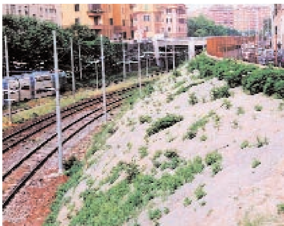
Primo piano dell'intervento
