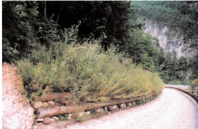
Palificata viva Ponte di muro, strada accesso imbocco Ferrovia Pontebbana (UD), agosto 2002
