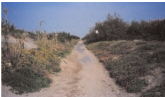
Dune costiere - Parco del Circeo Aprile 2003 Ricostruzione delle dune lato mare e abbandono e demolizione della strada asfaltata franata a suo tempo.
