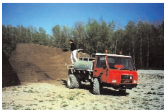
Foto 18.65 - Campione barriera antirumore in terrapieno in doppia terra rinforzata verde. Casalecchio Foto G. Sauli
