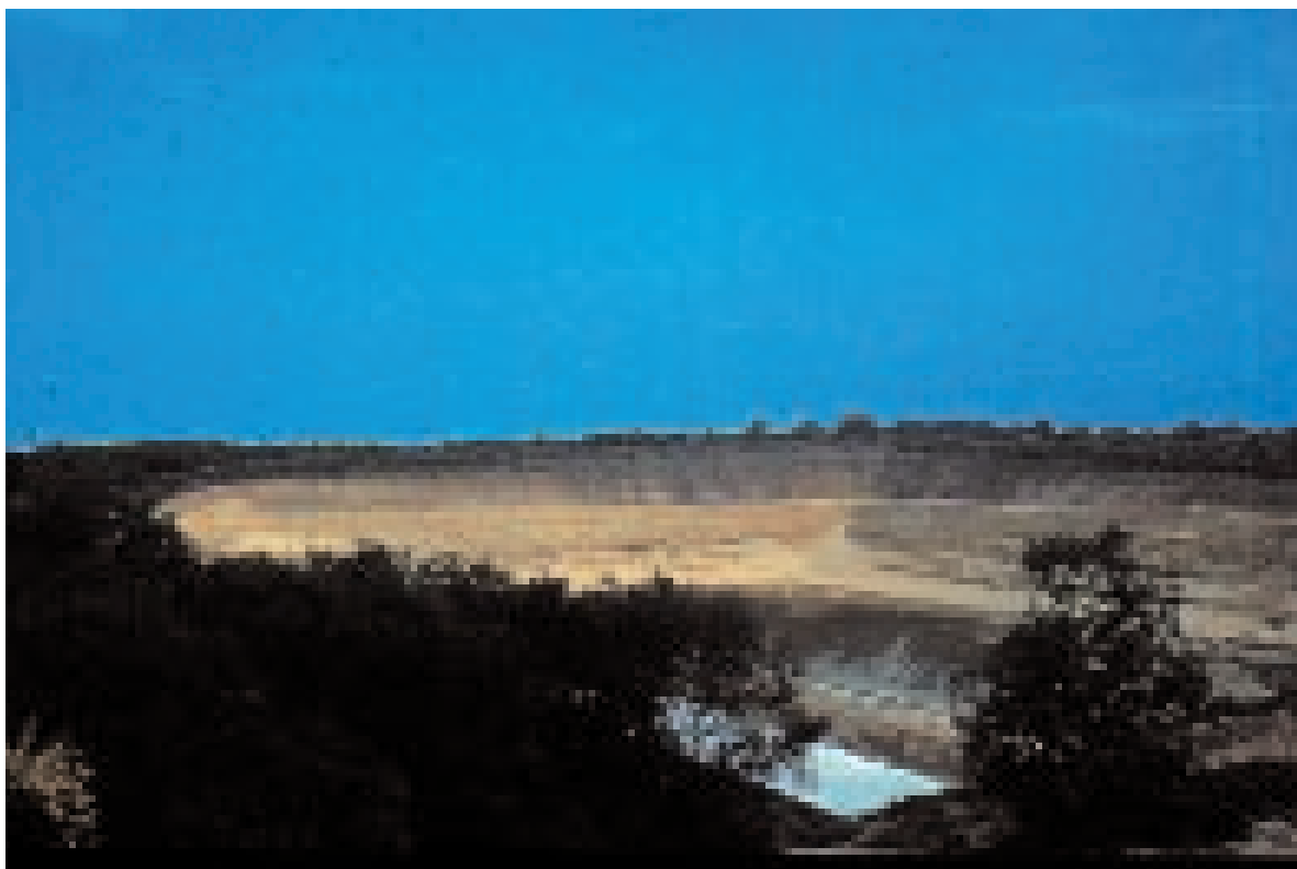
L'area durante i lavori di realizzazione della galleria a cielo aperto dopo lo sbancamento – anno 1987
