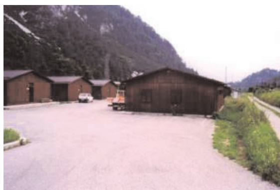
Foto 18.56 - Cantiere ditta Ferica, relativo al raddoppio della Ferrovia Pontebbana. Ugovizza (UD). Foto G. Sauli - 1999
