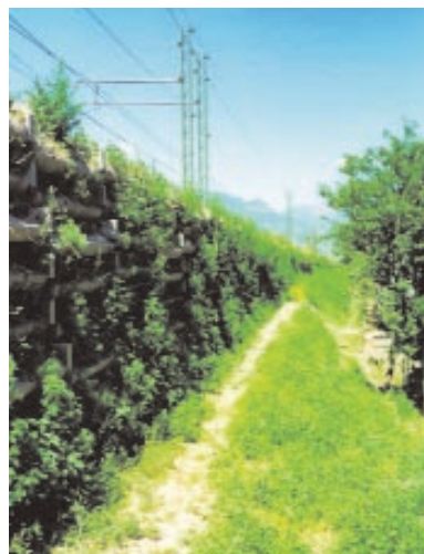
Foto 18.70 - Muro cellulare rinverdito in ambito ferroviario. Foto Geo-Ecostrutture
