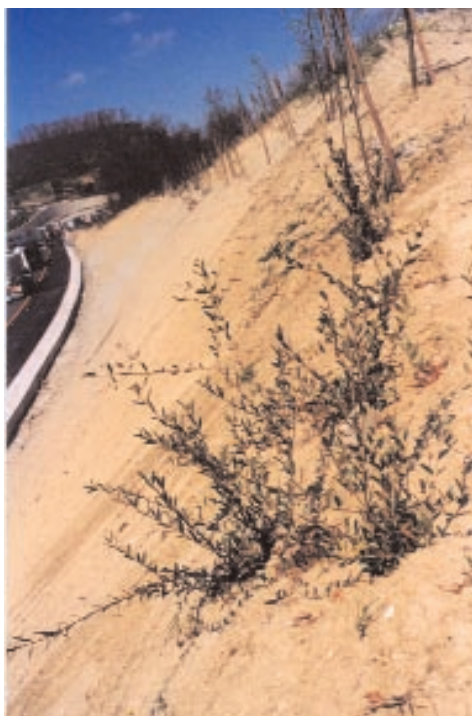
Foto 18.24 - Messa a dimora di arbusti della macchia mediterranea (mirto) su scarpate in trincea su litologia a matrice argillosa. 3a corsia Autostrada Orte-Fiano. Foto G. Sauli
