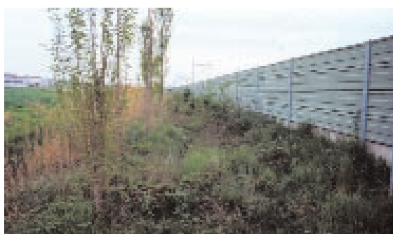
Foto 18.53 - Fascia boscata tampone di corredo a barriera fonoassorbente, dopo 1 anno. Scalo ferroviario di Cervignano (UD). Foto G. Sauli - 1986
