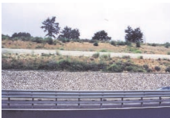
Foto 18.20 - Interventi strutturali di consolidamento di una scarpata in trincea in frana in micropali e muro in cls. Raccordo Roma nord - Foto G. Sauli
