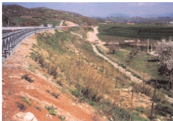
Foto 18.7 - Messa a dimora specie arboree su scarpata in rilevato - 3° corsia Autostrada Orte-Fiano. Aprile 2002 - Foto G. Sauli
