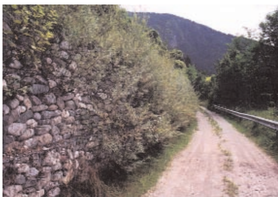
Foto 18.49 - Sostegno scarpata stradale in zona montana, con gabbionate rinverdate con talee di salice, inserite durante la costruzione, sino a toccare il terreno retrostante. Pista laterale di servizio Loc. Mogio (UD) Foto V. Zago - 2002
