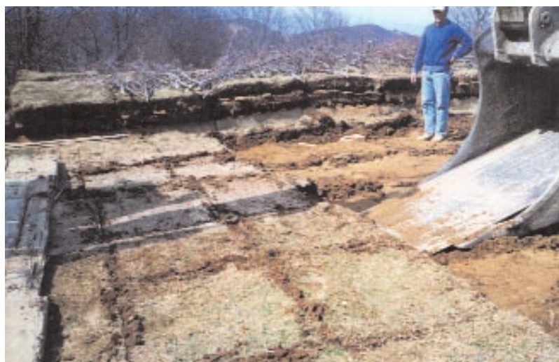
Trapianto di zolle su prati-pascoli naturali Metanodotto Pontremoli-Parma
