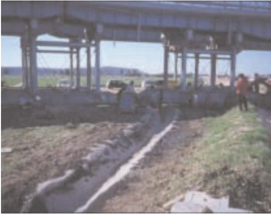
Foto 18.76 - Bitumatura del fosso in corso. Dicembre 1999. Foto P. Cornellini
