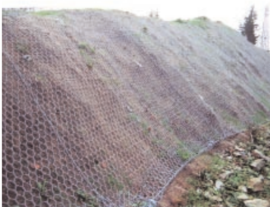
Foto 18.32 - Scarpata in roccia arenacea a 45° con rivestimento vegetativo in rete metallica e stuoia organica. Stazione FS Tarvisio - Boscoverde. Foto G. Sauli - 2000
