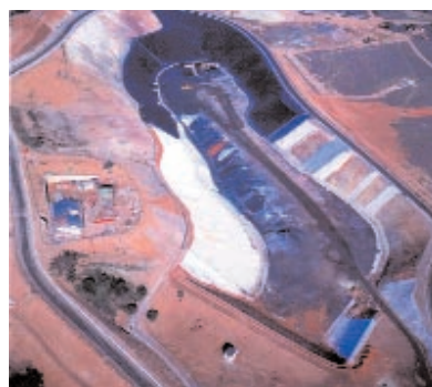
Foto 17.14 - Preparazione della sigillatura di fondo della discarica di fanghi industriali di Gennaluas (CA), su un rimodellamento morfologico della vecchia miniera di pirite. Foto Ecos
