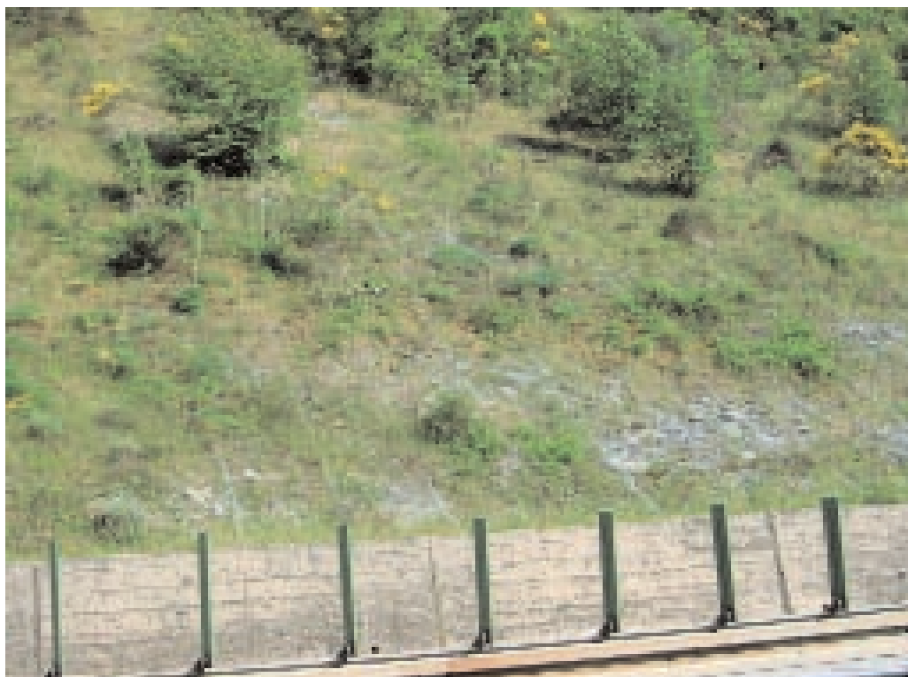
Vista d'insieme della scarpata con la rete zincata
