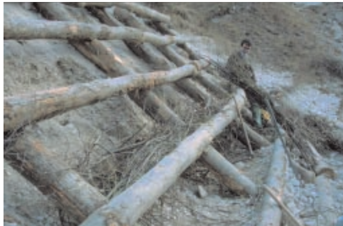
Grata con fascinate vive in costruzione Gemona (UD)
