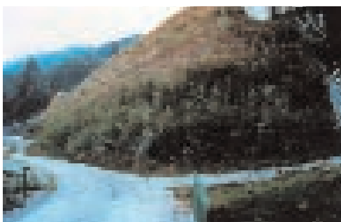
Foto 18.43 - La stessa terra rinforzata, con messa a dimora di talee di salice dopo alcuni anni. Foto G. Sauli
