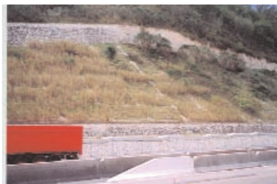
Foto 18.29 - Mantellate verdi su scarpate preesistenti. 3a corsia Autostrada Orte-Fiano aprile 2002. Foto G.Sauli
