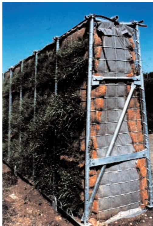
Barriera vegetativa antirumore a terrapieno compresso in sostegni metallici
