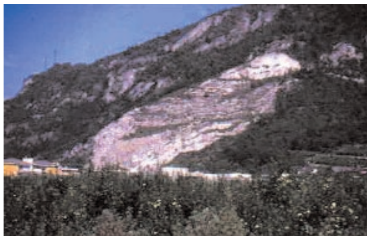
Foto 16.11 - Recupero della cava Melta (TN) con rivegetazione dei rilevati basali Foto: G. Sauli
