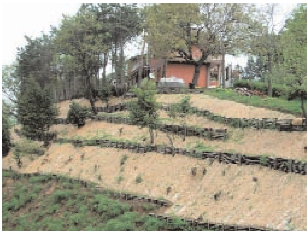
Biostuoia con viminate morte
