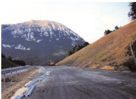
Foto 18.39 - Scarpata in trincea in roccia lavorata a bassa pendenza. Autostrada Capodistria-Lubiana, località Razdrto (Slovenia). Foto G. Sauli
