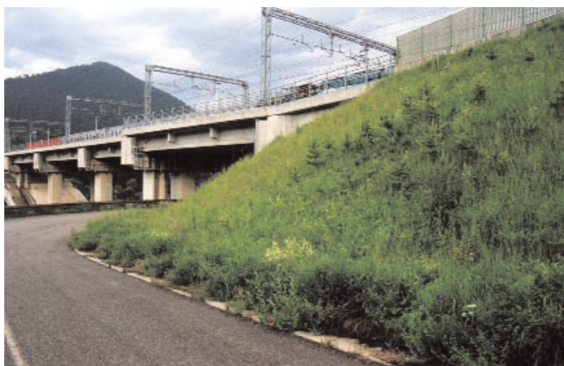
Rilevato ferrovia con alberi, stazione di Tarvisio-Boscoverde (UD)
