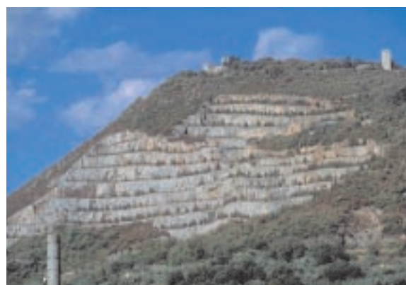
Foto 16.10 - Recupero con piantagione di resinose esotiche su gradoni, cava di Monsummano (PT), 2003 Foto: P. Binazzi
