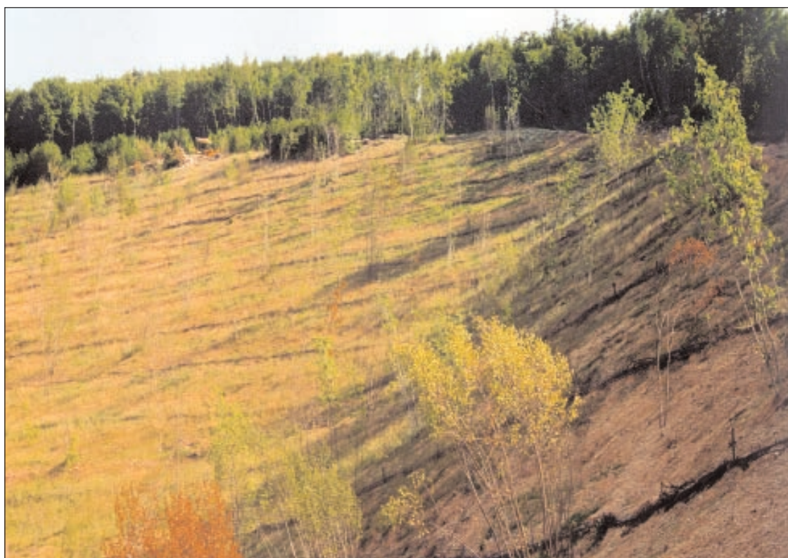
Foto 10b - Particolare intervento a lavori appena eseguiti
