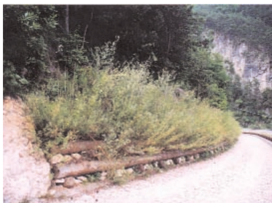
Foto 18.50 - Sostegno scarpata stradale in zona montana, con palificate vive in legname e pietrame, rinverdate con talee di salice. Pista laterale di servizio Loc. Ponte di Muro (UD). Foto V. Zago - 2002
