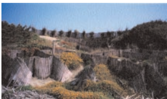
Dune costiere - Parco del Circeo Aprile 2003 Resti delle graticciate utilizzate per intrappolare la sabbia e limitare l'erosione. Nella parte alta fascine morte di Saggina.
