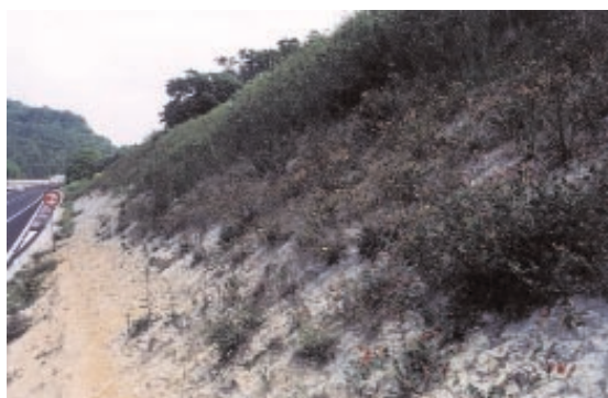
Foto 18.21 - Colonizzazione spontanea su scarpata in trincea in argilla di Arundo pliniana e Hedysarum coronarium . 3° corsia Autostrada Fiano - Orte. Foto G.Sauli
