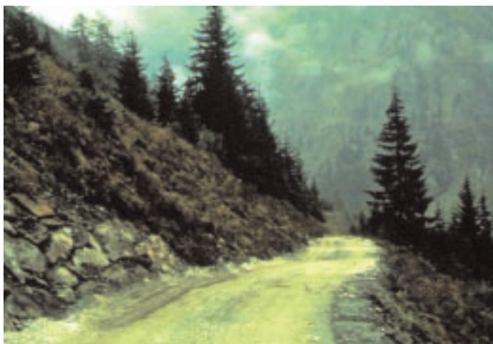
Trapianto di zolle erbose di prato alpino su scarpata stradale (Austria)
