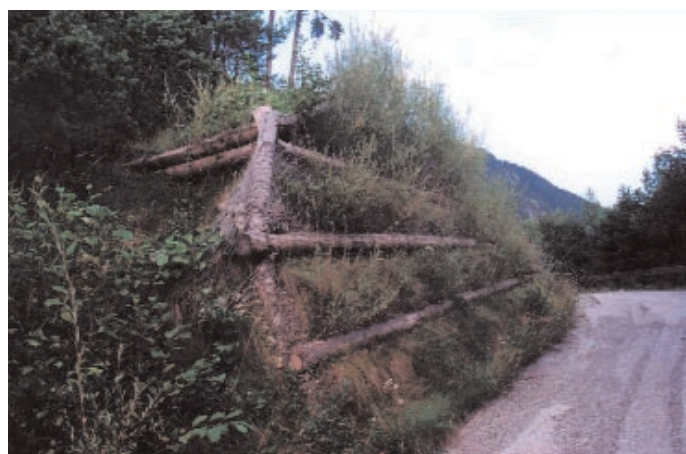
Consolidamento mediante grata viva Strada accesso imbocco 4 Ferrovia Pontebbana, (UD) agosto 2002
