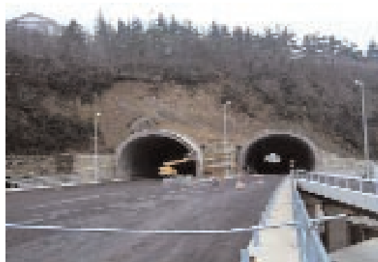
Foto 18.13 - Rivegetazione rilevati e crib-wall. Galleria di Servola. Grande viabilità triestina (TS) Foto G. Sauli - 1987
