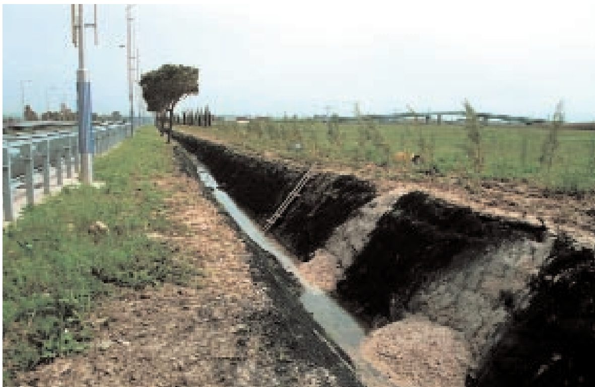
Un tratto di fosso appena ultimato giugno 2000 foto Polverino
