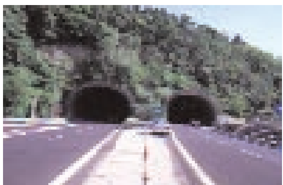
Foto 18.16 - Rivegetazione rilevati e crib-wall, Galleria di Servola. Grande viabilità triestina (TS). Foto G. Sauli - 2002
