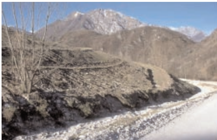
Gradonate vive (variante cordonate) presso Foto R. Ferrari discarica di inerti provenienti da macerie terremoto Gemona d.F (UD), dicembre 1998
