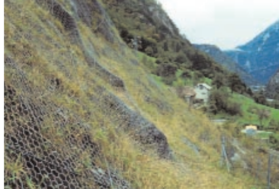
Foto 18.12 - Particolare rivestimento vegetativo in rete metallica a doppia torsione e geostuoia tridimensionale sintetica. Galleria di Pontebba (UD). Autostrada A23 - Carnia - Tarvisio. Ottobre 1987 - Foto G. Sauli
