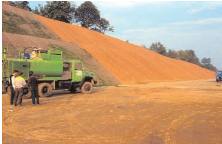
Stuoia in cocco Autostrada dei Trafori, ottobre 1988
