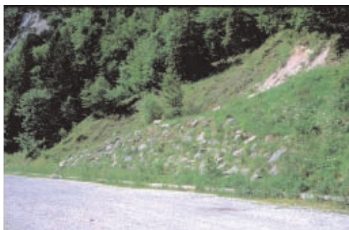
Muro a secco rinverdito su strada Val Trenta, Slovenia
