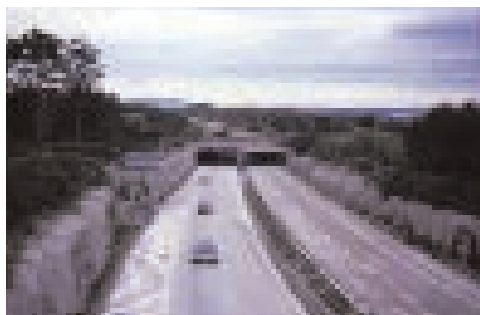
Foto 18.81 - Galleria artificiale rivegetata con funzione di sovrappasso per ungulati in zona carsica. Superstrada Trieste-Lisert Foto. G. Sauli
