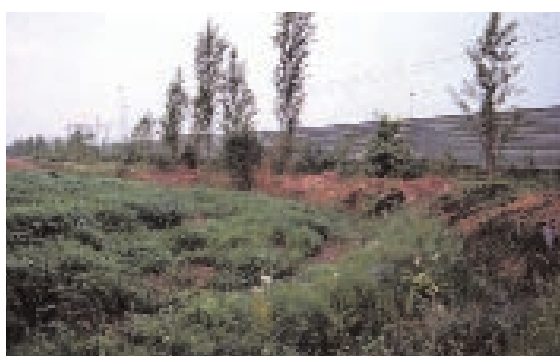
Foto 18.52 - Formazione fascia boscata tampone di corredo a barriera fonoassorbente. Scalo ferroviario di Cervignano (UD). Foto G. Sauli - 1985
