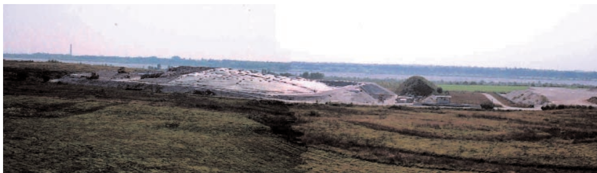
Foto 17.7 – Discarica di RSU di Maniago (PN) Loc. Cossana. Rinverdimento del I° lotto visibile a sinistra dell'immagine. Foto: G. Sauli - 2002
