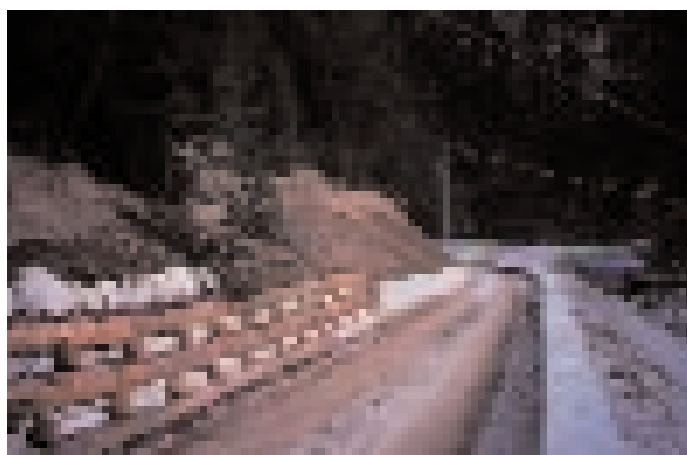
Palificata viva, appena realizzata Ponte di muro, strada accesso imbocco Ferrovia Pontebbana (UD), 2001
