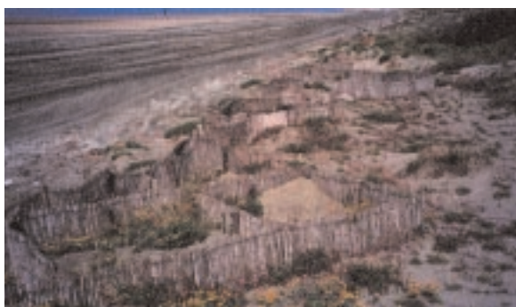
Dune costiere - Parco del Circeo Aprile 2003 Resti delle graticciate utilizzate per intrappolare la sabbia e limitare l'erosione.
