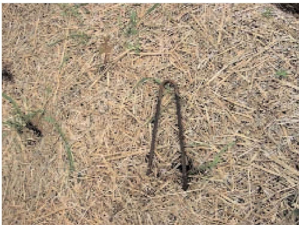
Picchetto a U in acciaio per l' ancoraggio della biostuoia
