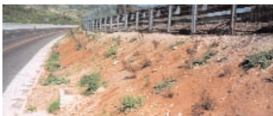
Foto 18.2 - Messa a dimora arbusti su scarpata tra le carreggiate. 3° Corsia Autostrada Orte-Fiano - Foto G. Sauli, aprile 2003
