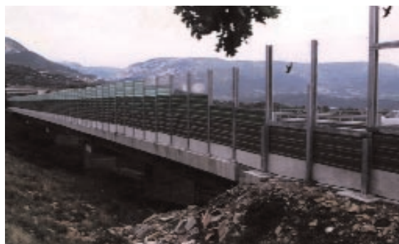
Foto 18.74 - Pannelli antirumore con sagome falchiformi antischiando per uccelli. Grande Viabilità di Trieste. Foto G. Sauli
