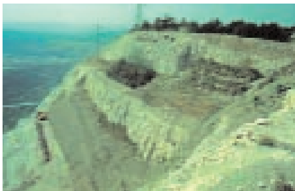
Foto 16.18 - Ricomposizione morfologica su cava a gradoni Cava Scoria (TS), 1998 Foto: G. Sauli
