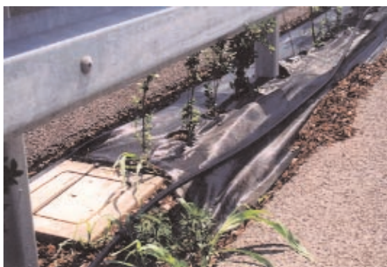
Foto 18.1 - Siepe di Ligustro con pacciamatura tra le carreggiate - Autostrada Udine-Palmanova - Foto G. Sauli - Giugno 2003
