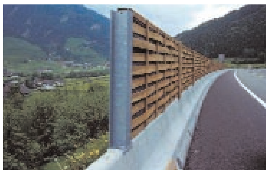
Foto 18.60 - Pannelli fonoassorbenti in legno. Autostrada dei Tauri presso Salisburgo. Foto G. Sauli - giugno 1981
