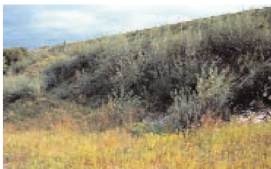
Foto 18.3 - Piantagione di arbusti autoctoni e talee di salice arbustivi su rilevato autostradale. Carso triestino Loc. Slivia (TS). Dopo 5 anni. Foto G. Sauli 1996
