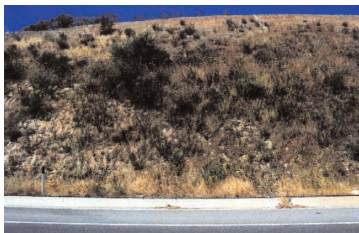
Rete metallica con funzione antierosiva Nuova SS 195 Km 18 per Pula (CA), settembre 2003
