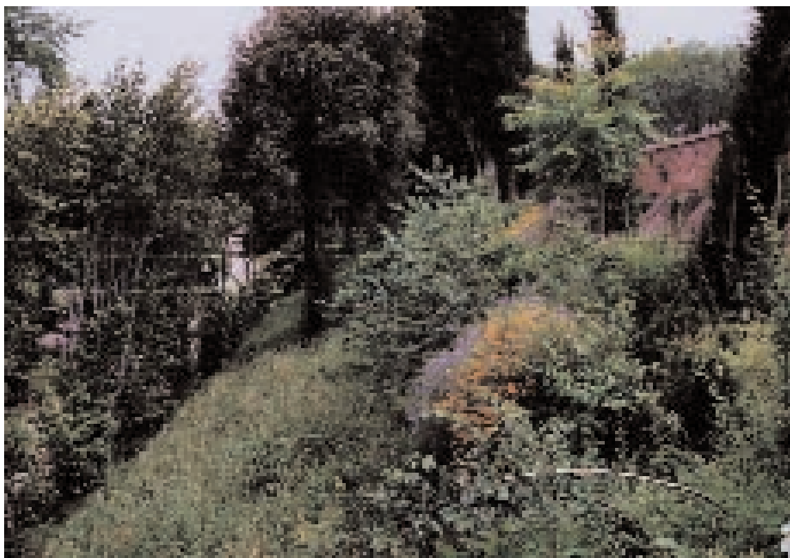
Primo piano della palificata viva
