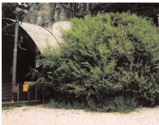
Foto 18.45 - Terra rinforzata verde di sostegno laterale terrapieno di ricomposizione morfologica sul prolungamento artificiale di una galleria ferroviaria a 3 anni dall'intervento. Loc. S. Caterina (UD) - Rad-doppio Ferrovia Pontebbana. Foto G. Sauli
