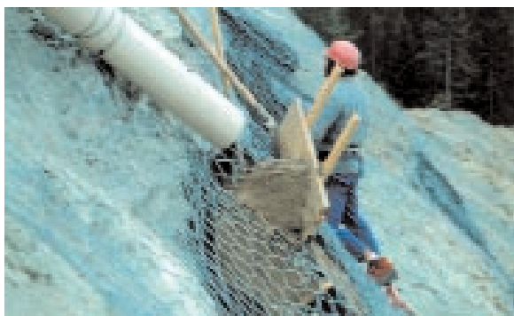
Foto 16.30 - Riempimento tasche in rete con terreno sabbioso Miniera di Giustino, ottobre 1986 Foto: G. Sauli
