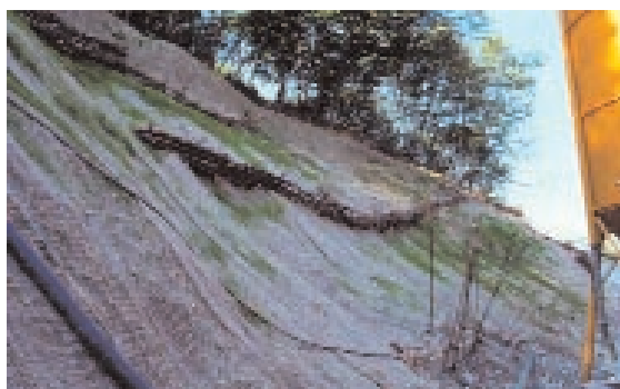
Foto 18.31 - Rivestimento antierosivo di scarpate in stuoia in juta, Autostrada Vittorio Veneto - Pian di Vedoia. Settembre 1988 - Foto G.Sauli
