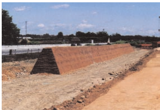
Foto 18.64 - Terrapieno antirumore in doppia terra rinforzata verde. Ferrovia Alta velocità To-MI presso Novara Maggio 2003. Foto Maccaferri
