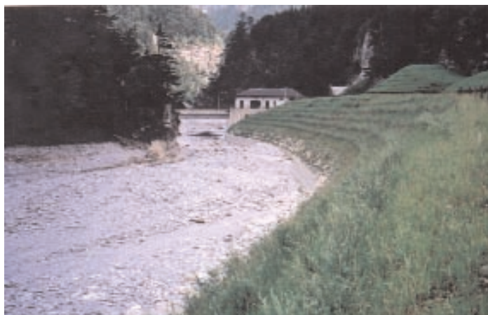
Gradonate vive Ferrovia Pontebbana, Stazione S. Caterina (UD), agosto 2002
