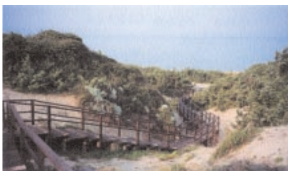
Parco del Circeo Aprile 2003 Le scale in legno per la discesa a mare hanno limitato l'erosione di origine antropica
