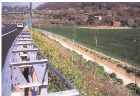
Foto 18.6 - Messa a dimora specie arboree su scarpata in rilevato - 3° corsia Autostrada Orte-Fiano. Aprile 2002 - Foto G. Sauli
