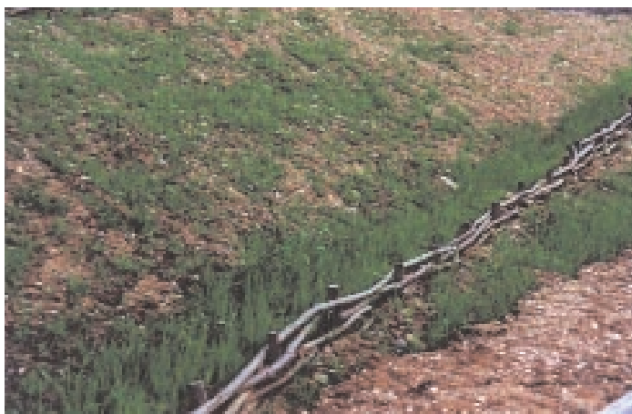
Viminate vive presso imbocco 1 Ferrovia Pontebbana San Leopoldo (UD), 1999
