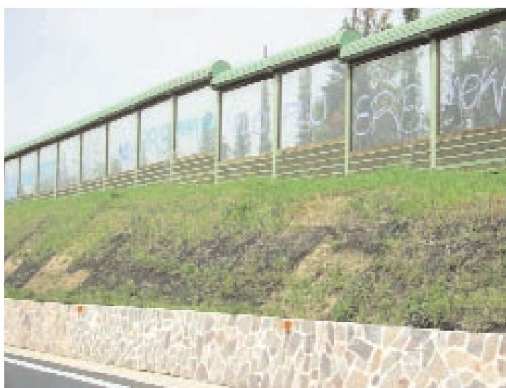
Geostuoia tridimensionale sintetica GRA Roma uscita EUR lato interno
