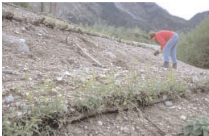
Gradonate vive (variante cordonata) presso Foto R. Ferrari discarica di inerti provenienti da macerie terremoto Gemona d.F.(UD), primavera 1999
