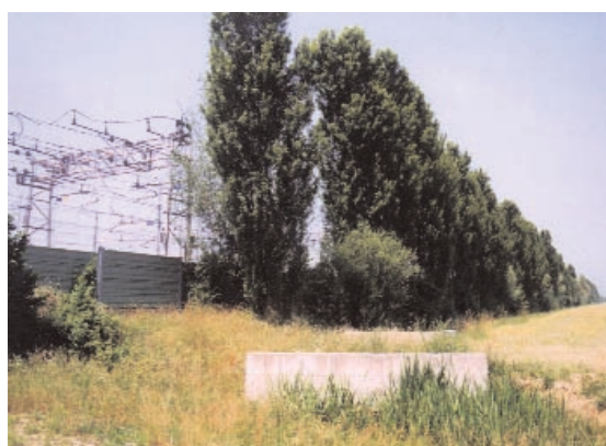
Foto 18.54 - Fascia boscata tampone, a circa 18 anni dall'intervento in Loc Muscoli. Scalo ferroviario di Cervignano (UD).Foto G. Sauli - 2003
