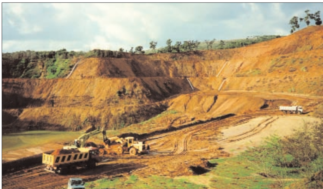
Foto 3b - Riassetto morfologico: realizzazione della gradonatura nelle scarpate finali e messa in opera delle canalette di drenaggio
