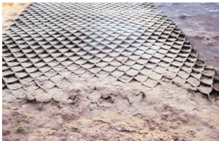
Geocelle in materiale sintetico su rilevato autostradale (Pavia), maggio 1991
