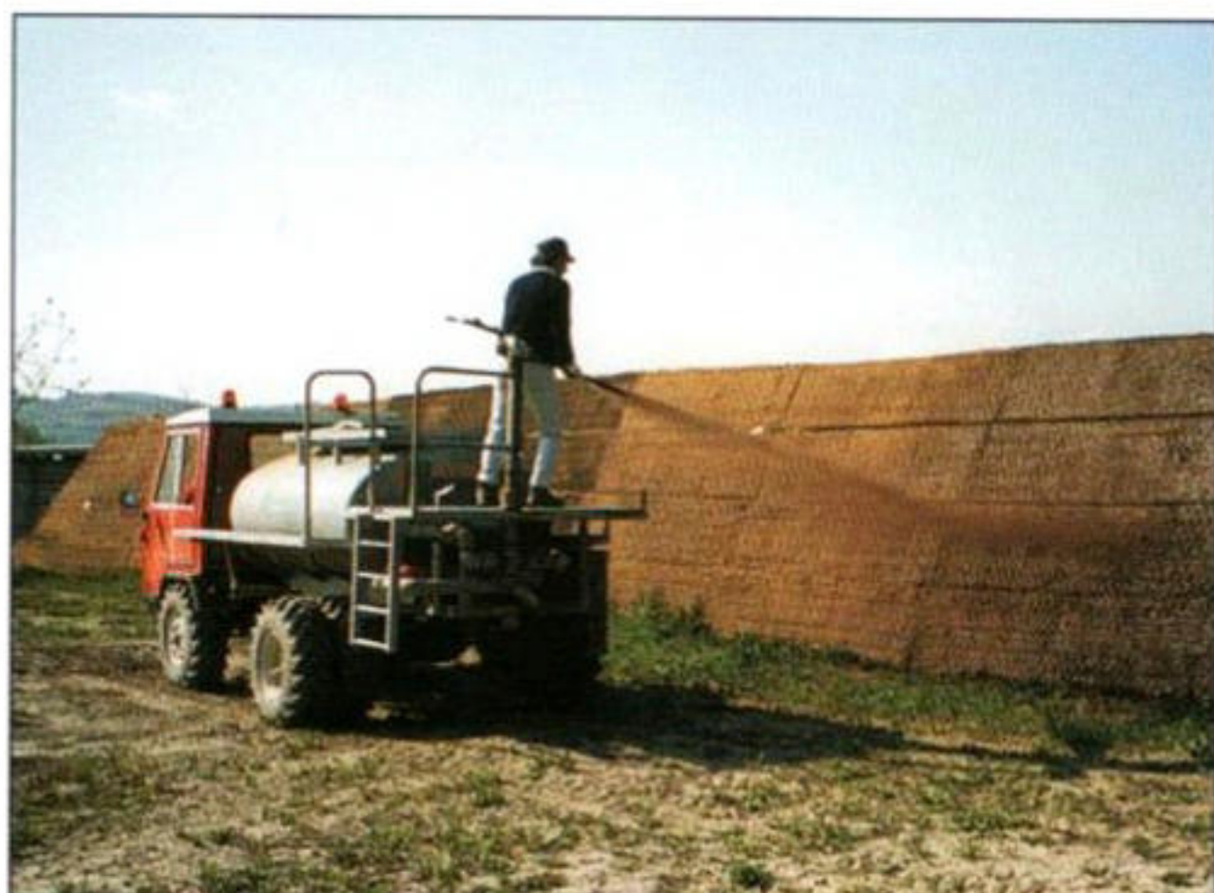
Foto 23 : Idrosemina a spessore - Foto G. Sauli.
