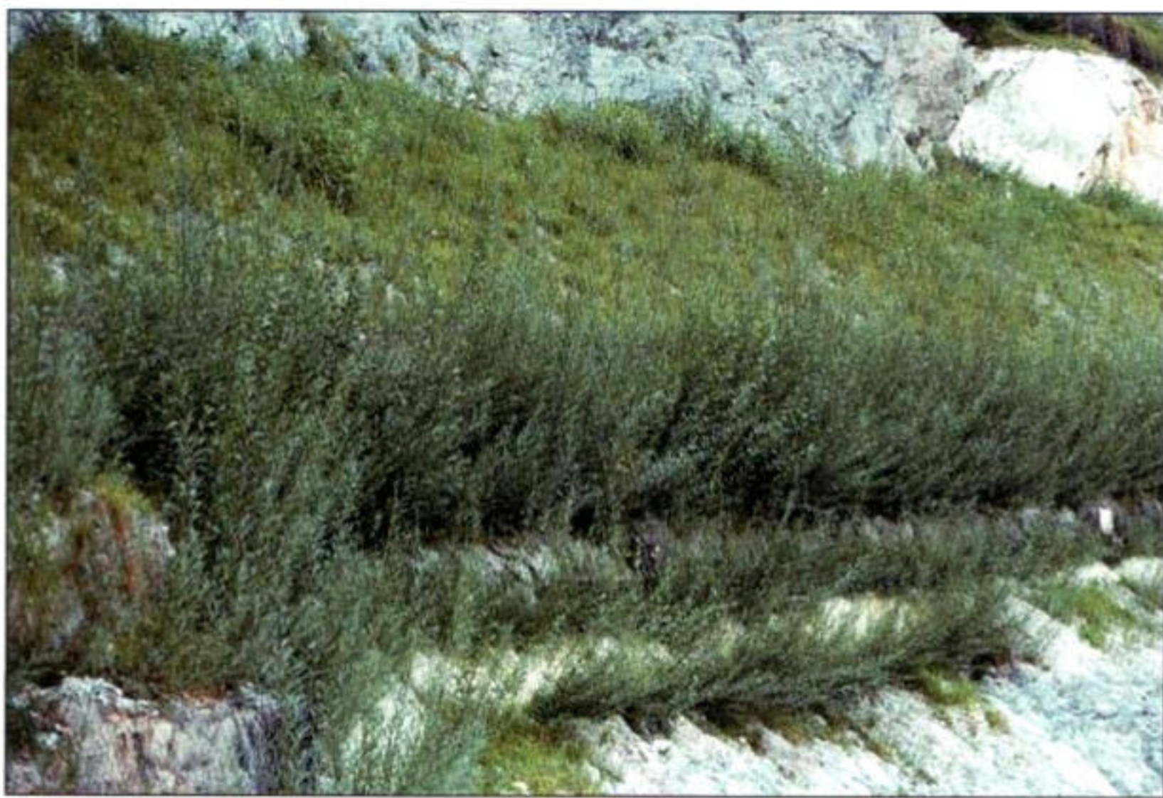
Foto 42: Interventi di ricomposizione morfologica e rivegetazione con rilevati sostenuti da gabbionate e terre rinforzate verdi dopo 1 anno (1987), Miniera di Giustino-Val Rendeva (TN) - Foto G. Sauli.
