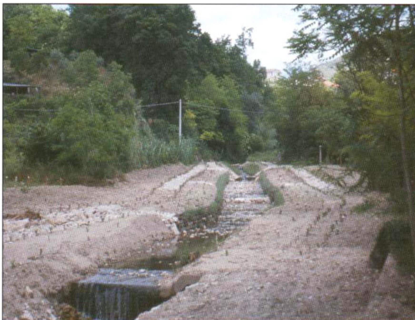
Foto 3: Realizzazione di tratto di alveo artificiale con palificate spondali, scogliera rinverdita, fascinate vive e soglie in pietra. Rio Inferno (FR) (Maggio 2000) - Foto P. Cornellini.
