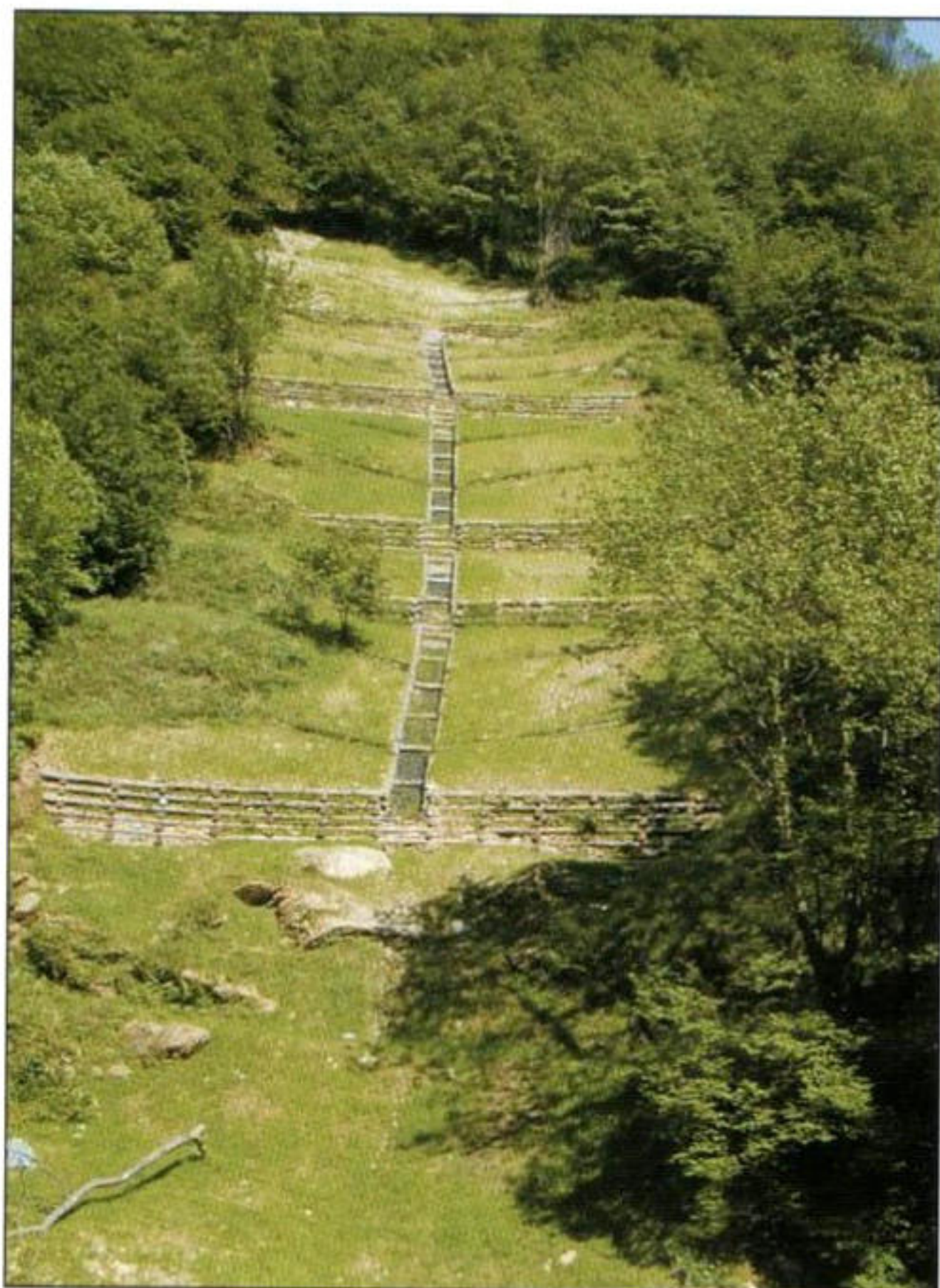
Foto 19: Frana T. Cardoso sistemata con palificate vive tirantate e drenaggi (Versilia, Maggio 2000) - Foto A. Trigila.
