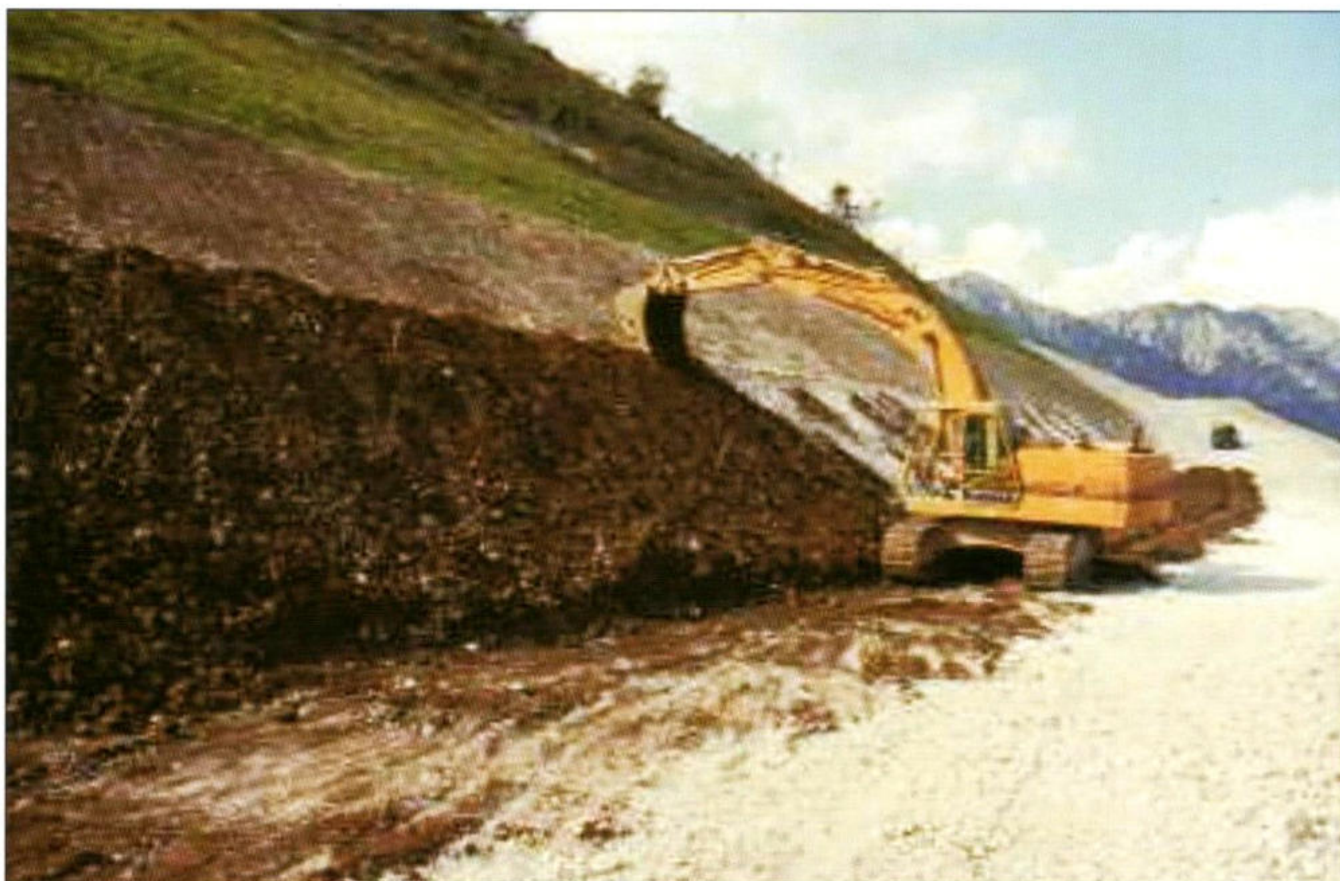
Foto 39: Cava di calcare del M. S. Lorenzo di Fanna (PN). Fase di stesura della terra vegetale 1995 - Foto G. Sauli.
