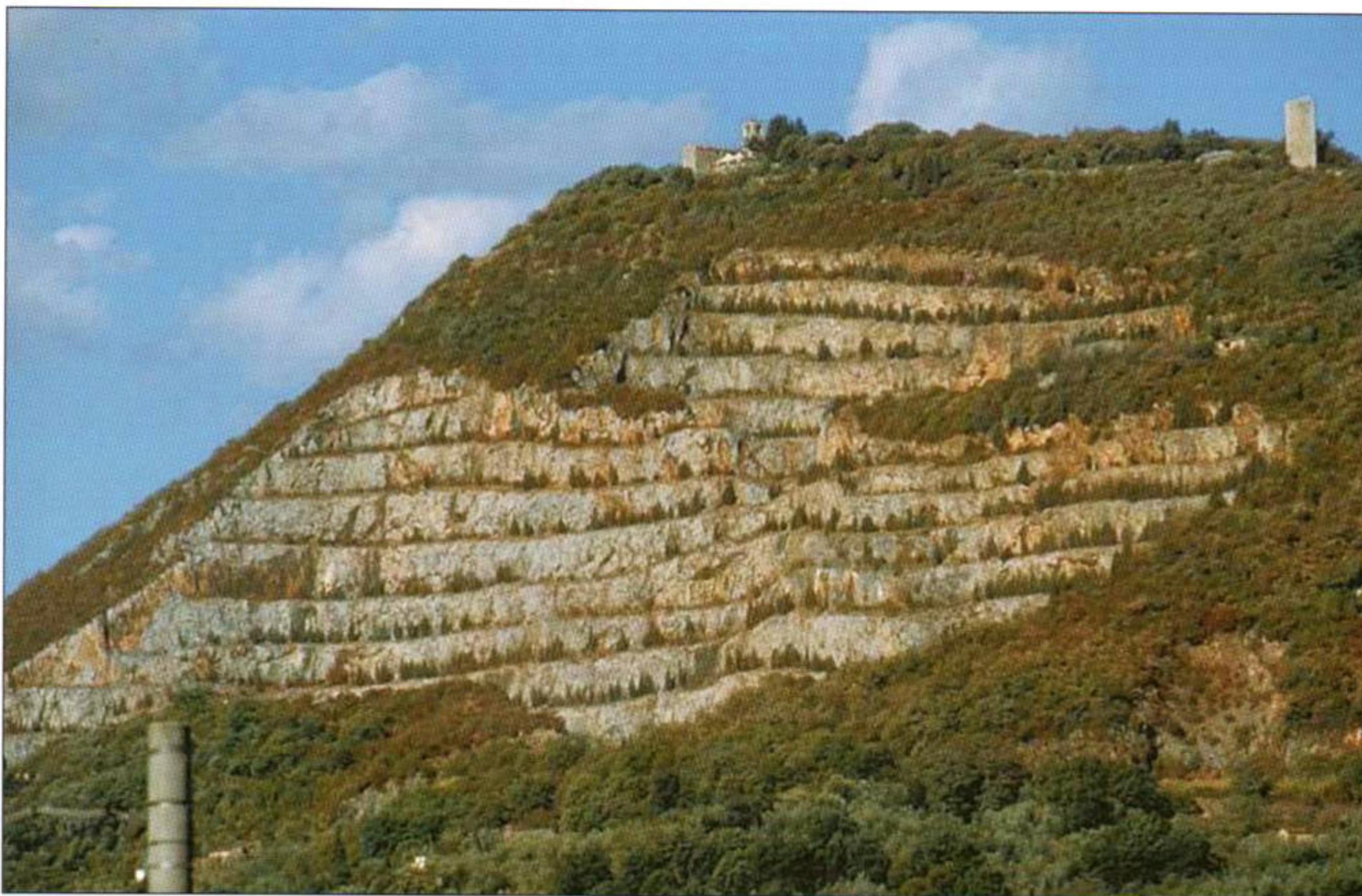
Foto 40: Recupero scadente con piantagione di resinose esotiche su gradoni, cava di Monsummano (PT), 2003 - Foto P. Binazzi.
