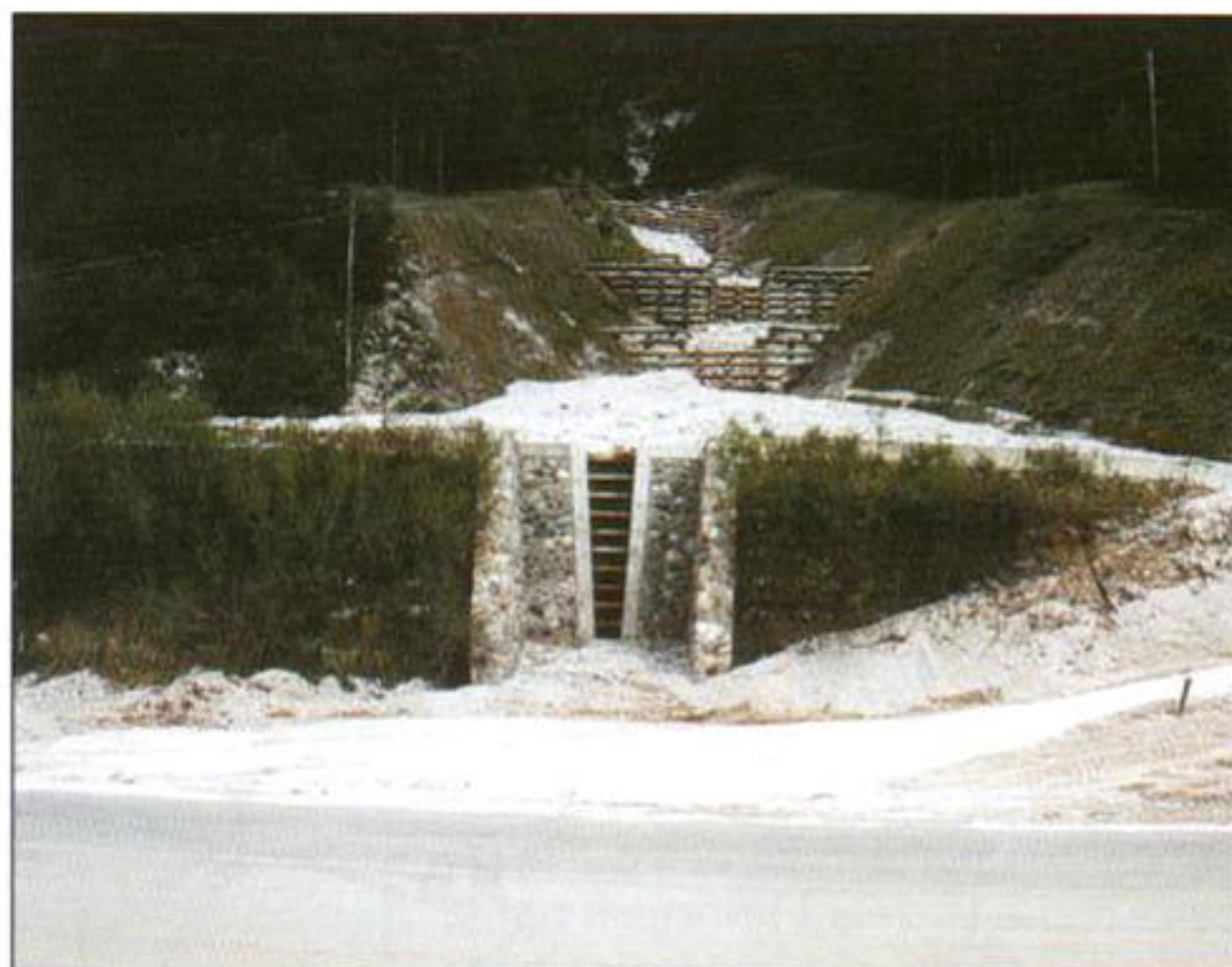
Foto 8: Rio Anonimo, resistenza delle opere post alluvione 29 agosto 2003. Foto G. Sauli.
