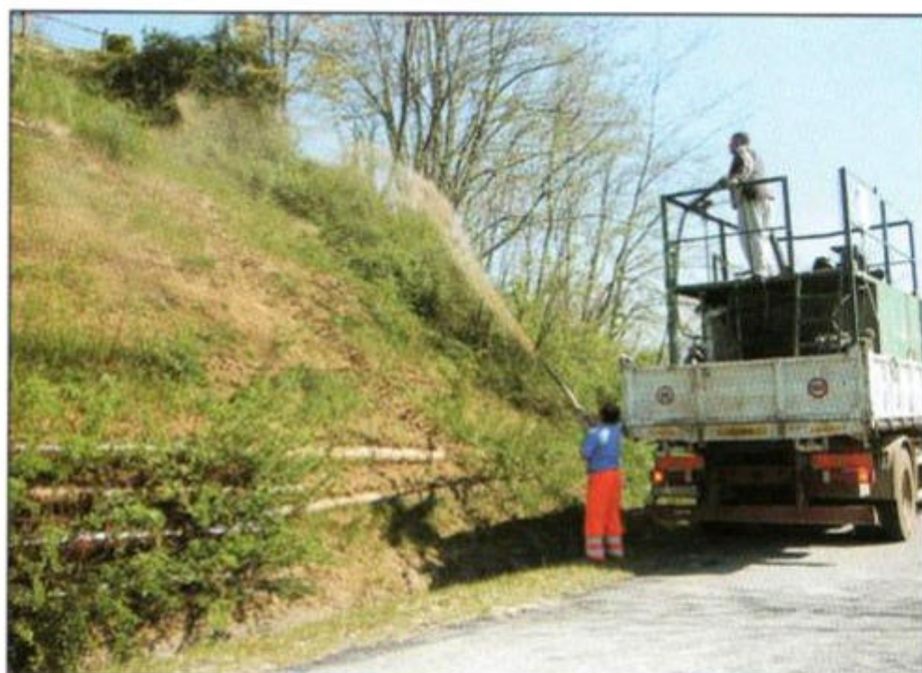
Foto 9: Idrosemiatrice su scarpata (aprile 2002) Atina (FR) Foto P. Cornolini.
