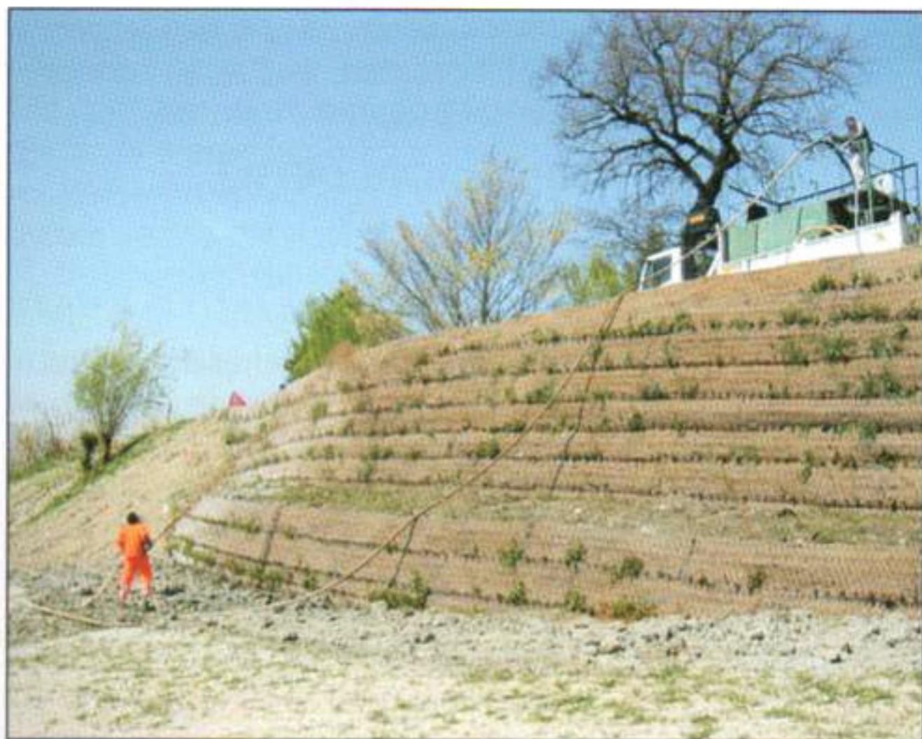
Foto 25: Idrosemina potenziata sulla terra rinforzata rinverditata (Marzo 2002) Atina (FR) - Foto P. Cornolini.
