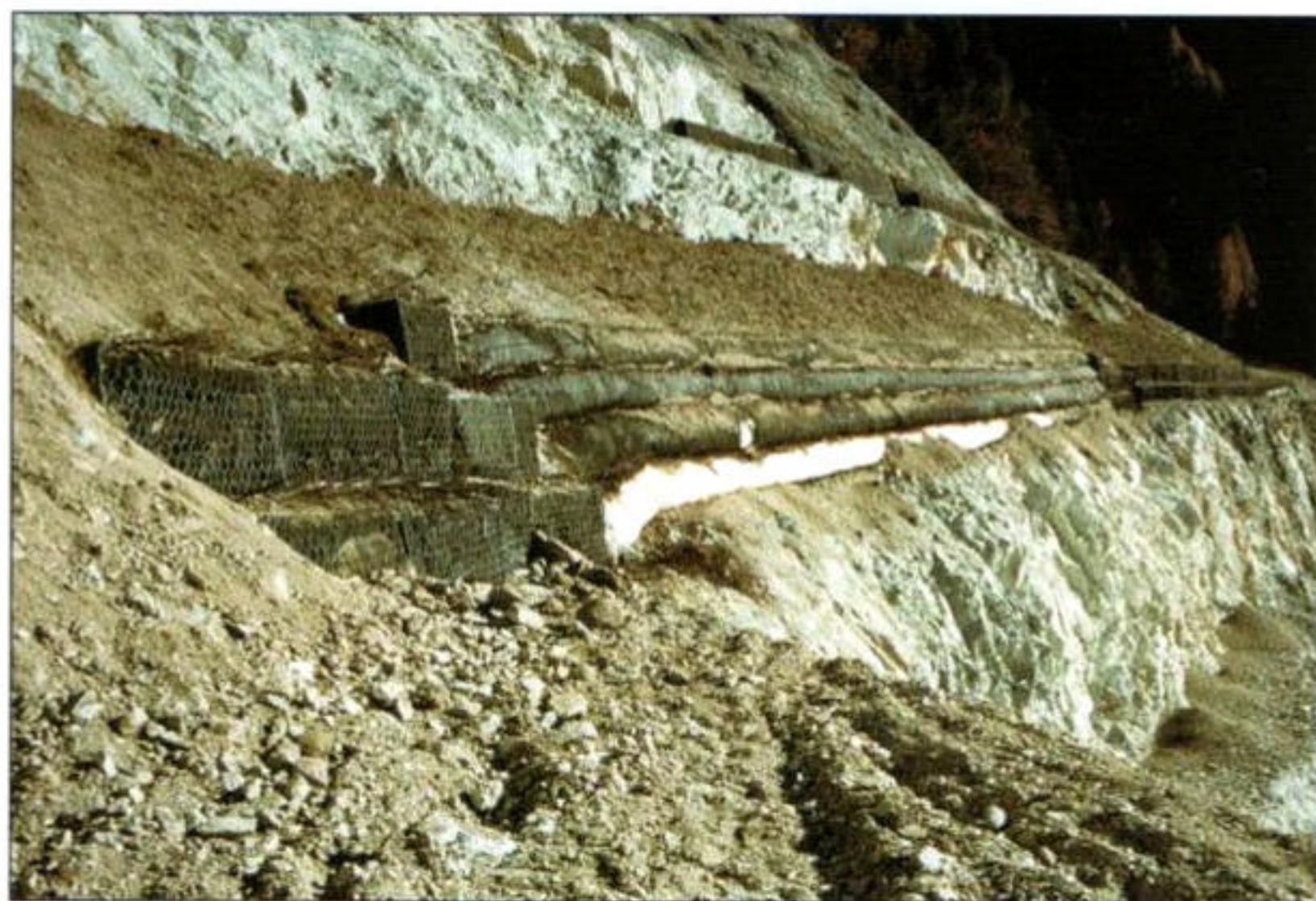
Foto 41: Interventi di ricomposizione morfologica e rivegetazione con rilevati sostenuti da gabbionate e terre rinforzate verdi durante i lavori (1986), Miniera di Giustino Val Rendeva (TN) - Foto G. Sauli.
