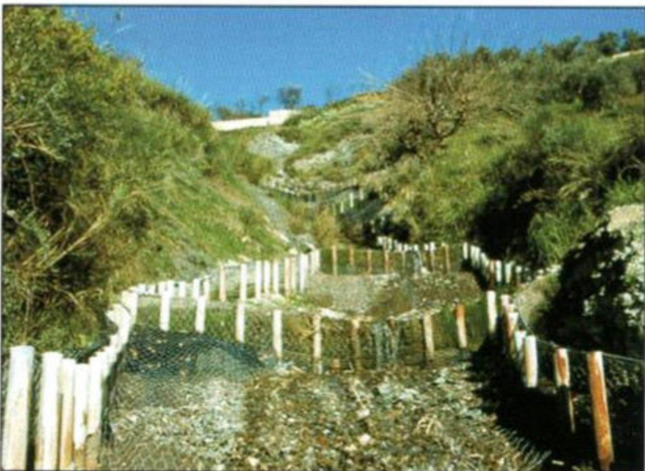
Foto 14: Graticciate in micropali corten, reti metalliche e stuoie tridimensionali per consolidamento impluvi in rocce friabili T. Giarina (ME) - Foto G. Sauli.
