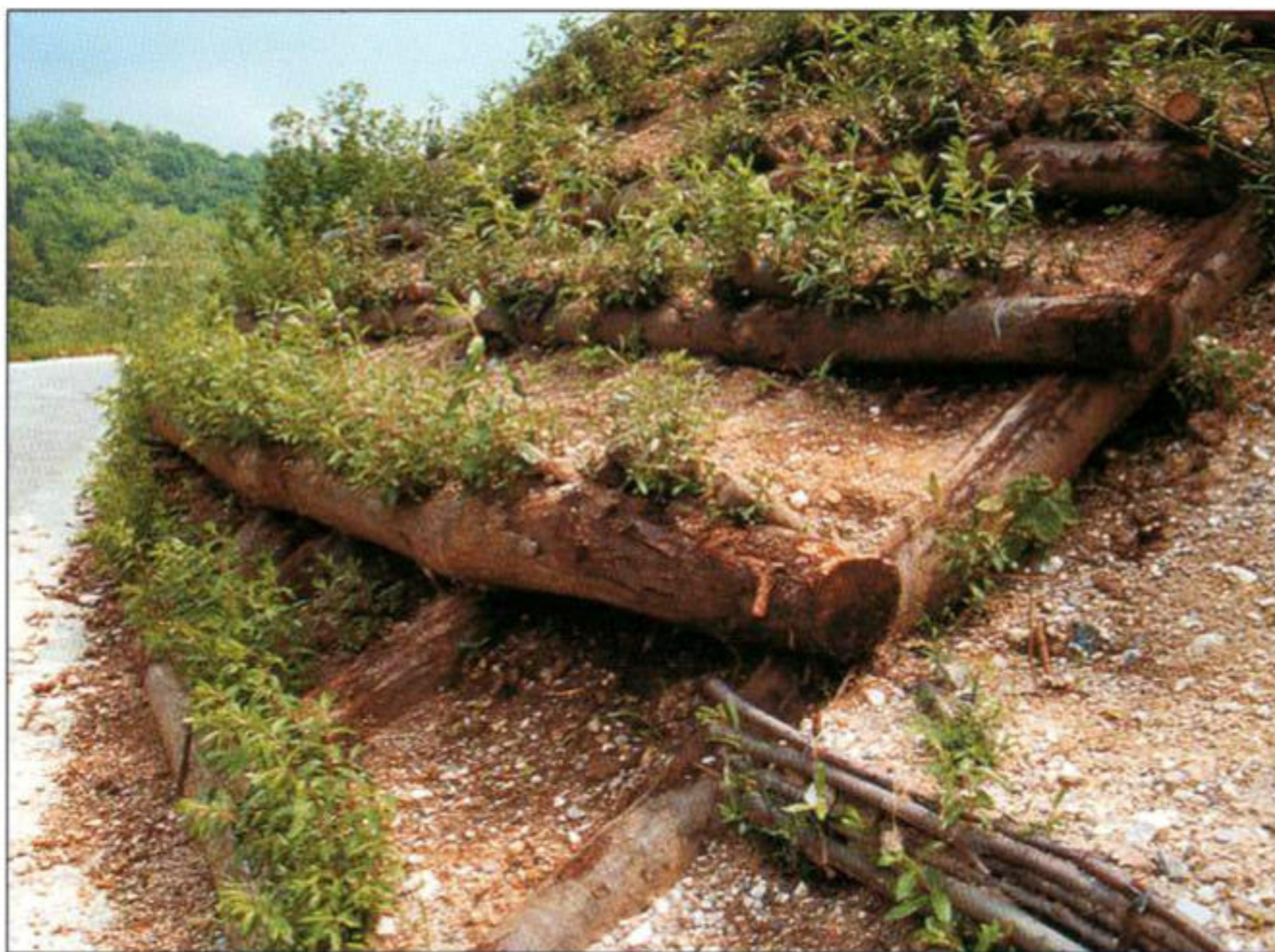
Foto 32: Grata viva su scarpata in trincea Montenars (UD) Rivegetazione - Foto G. Sauli.
