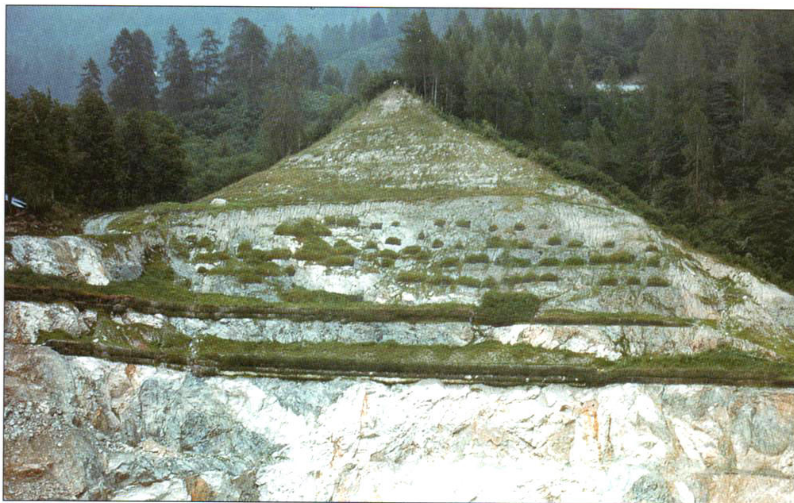
Foto 43: Realizzazione di materassi a sacche in rete metallica e stuoia sintetica tridimensionale riempite di terreno e rivegetate Miniera di Giustino Val Rendeva (TN), visione d'insieme (1996) - Foto G. Sauli.
