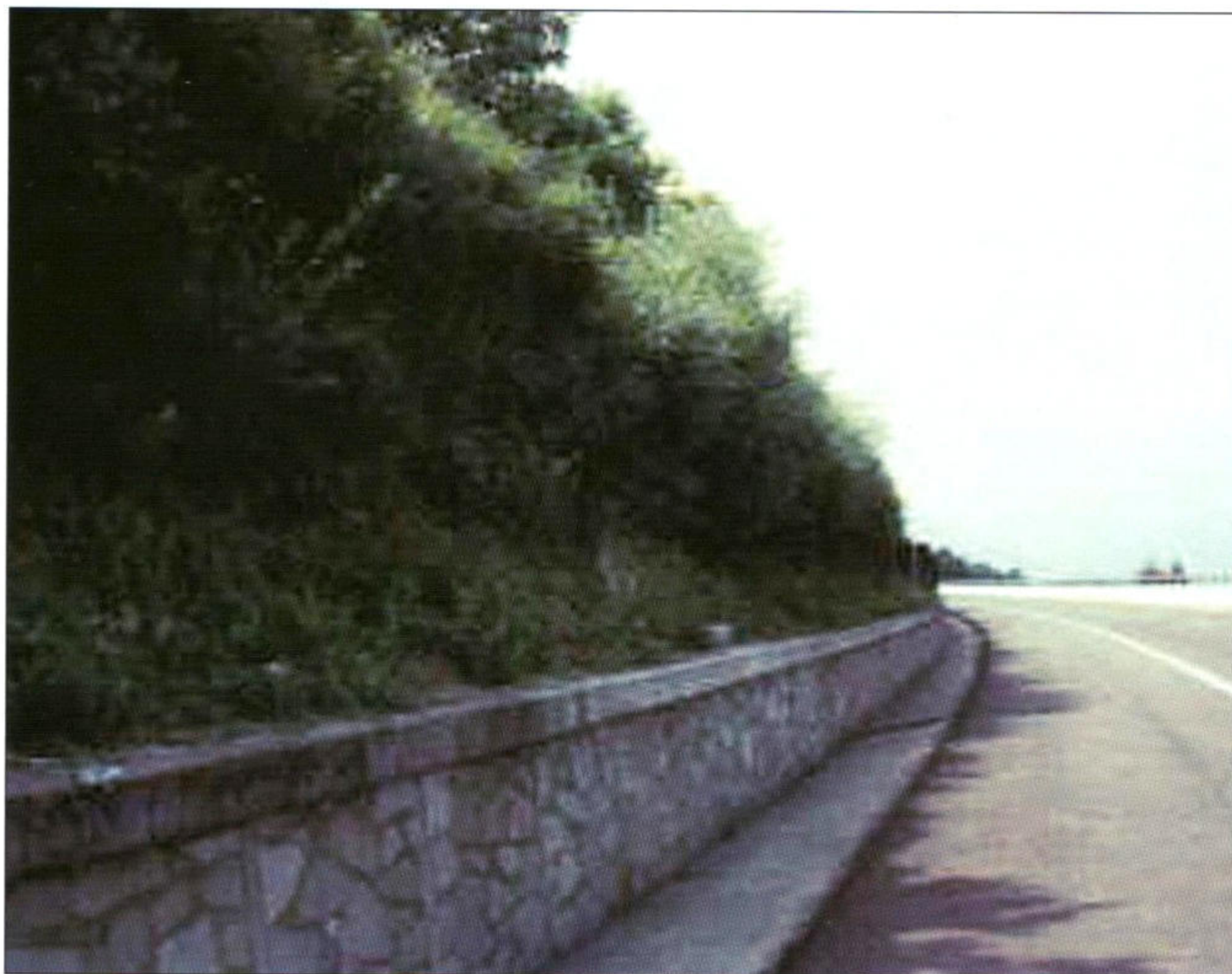
Foto 36: Barriera vegetativa antirumore in terrapieno compresso dopo 10 anni (Autostrada dei Trafori - Loc. Baveno) - Foto G. Sauli.
