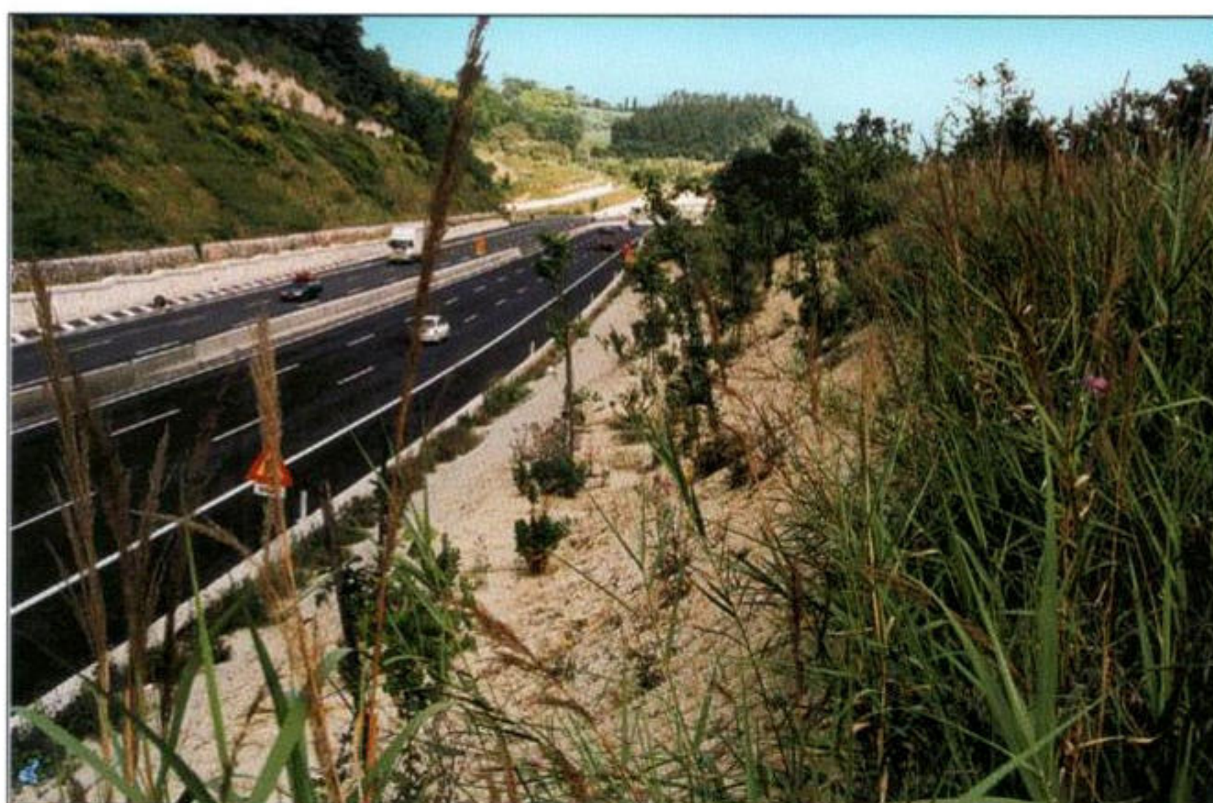
Foto 29: Colonizzazione spontanea di scarpate in argilla con Arundo pliniana , Hedysarum coronarium (3° corsia Autostrada Fiano-Orte) - Foto G. Sauli.
