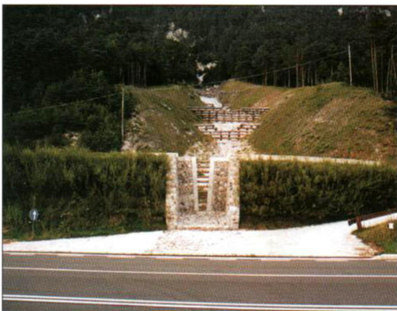
Foto 7: Rio Anonimo (Tarvisio), post operam 2002: briglie vive e terre rinforzate verdi. Foto G. Sauli.
