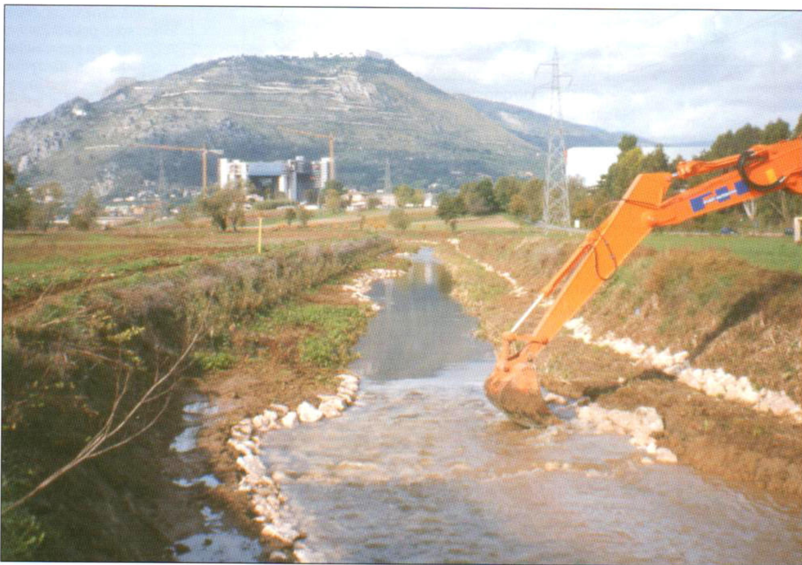
Foto 5: Lavori per l'aumento della biodiversità all'interno dell'alveo del Rio Fontanelle (FR) (Ottobre 2001) - Foto P. Cornolini.
