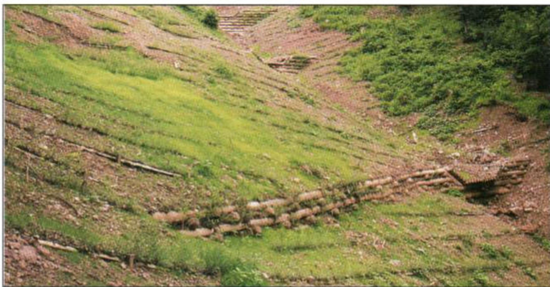
Foto 17: Sistemi di consolidamento e stabilizzazione di impluvi montani mediante briglie in legname e pietrame e cordone vive Ligosullo (UD) - Foto G. Sauli.
