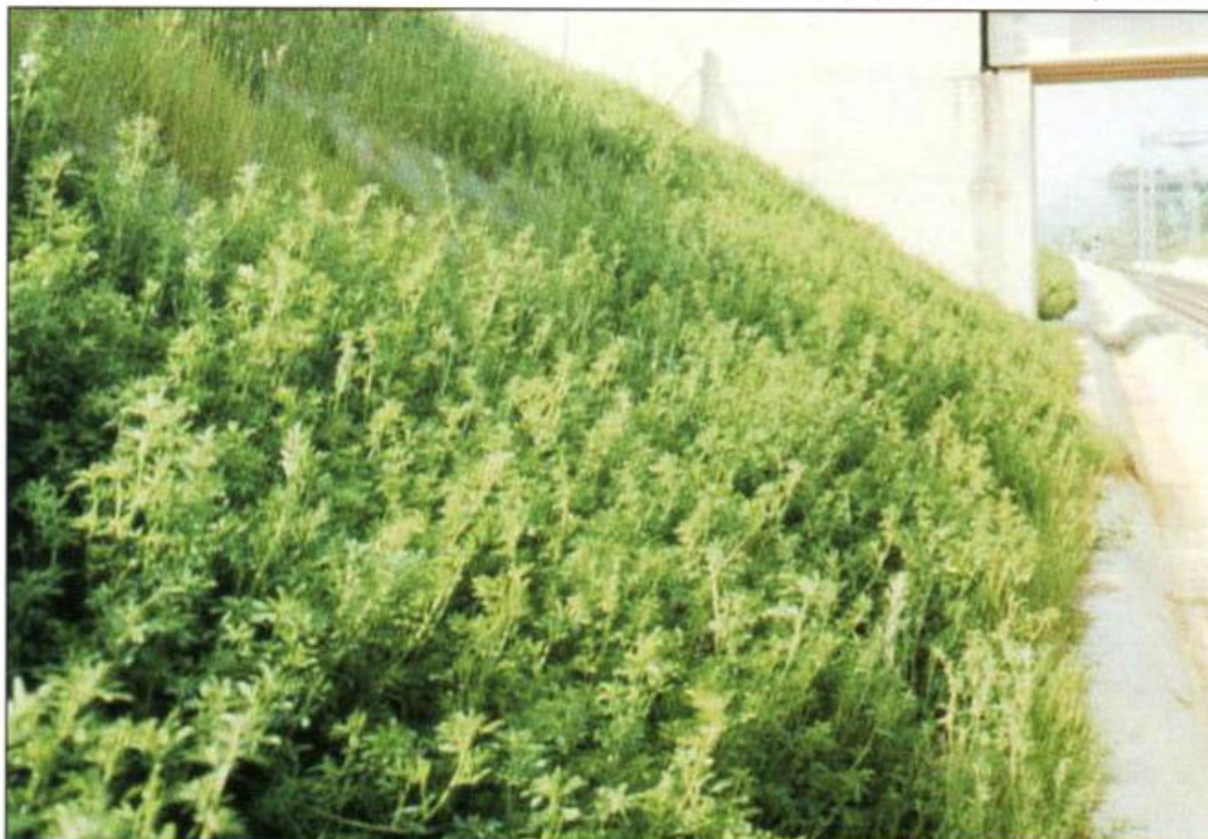
Foto 27: Scarpata con copertura a lupinella linea ferroviaria DD RM-FI presso Arezzo (Aprile 1990) - Foto P. Cornolini.
