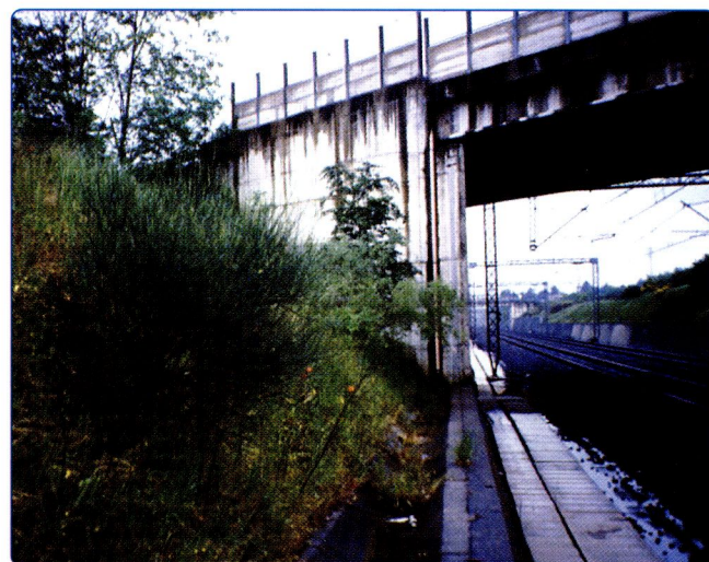
Fig. 7 - Stabilizzazione delle scarpate della DD Roma-Firenze con rivestimenti vegetativi (paglia, reti zincate, idrosemina e messa a dimora di talee) presso l'interconnessione di Arezzo Nord. Maggio 2001, a 11 anni dalla realizzazione
