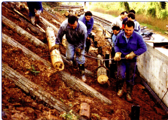
Fig. 8 - Sistemazione della frana sulla scarpata ferroviaria della linea Savona-Torino, località Cadibona (SV). Novembre 1994
