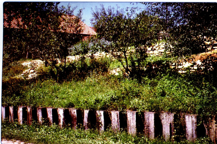
Fig. 2 - Impiego di traverse ferroviarie come opere di sostegno. Potenziale uso per opere di ingegneria naturalistica. Agosto 2001
