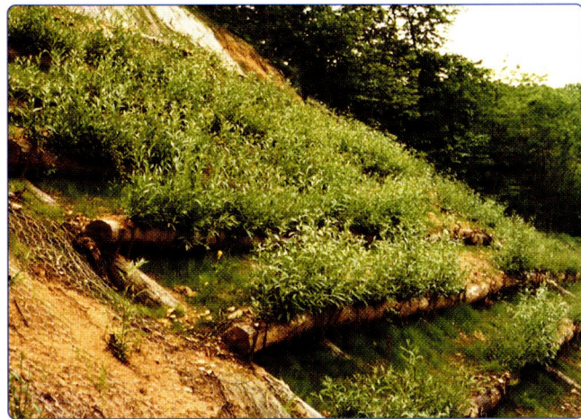
Fig. 9 - Grata viva a 6 mesi dalla realizzazione
