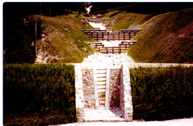
Fig. 11 - Briglie filtranti e briglie in legname e pietrame per la sistemazione dei versanti lungo la nuova linea Pontebbana (Udine-Tarvisio). Giugno 2001
