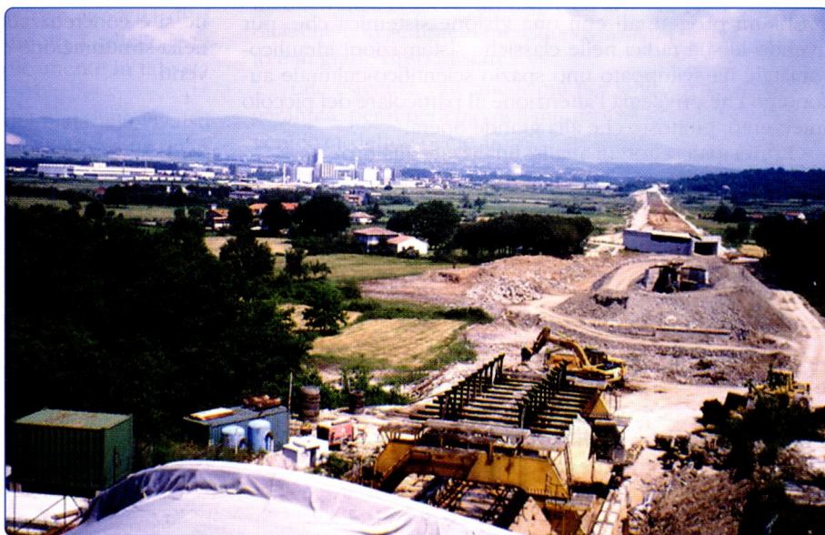
Fig. 1 - Gli interventi di ingegneria naturalistica rappresentano l'ultima fase di un corretto iter di progettazione ambientale e non devono essere utilizzati per giustificare carenze progettuali
