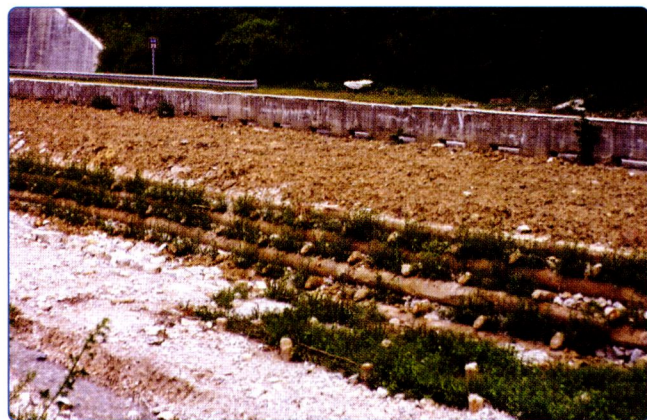
Fig. 10 - Palificate vive spondali per la sistemazione di corsi d'acqua lungo la nuova linea Pontebbana (Udine-Tarvisio). Giugno 2001
