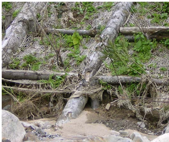
Il sito A, dopo la piena del 30 gennaio 2006: accumulo di materiale fino nella parte a monte (a sinistra) ed erosione al piede della grata nella parte a valle.
