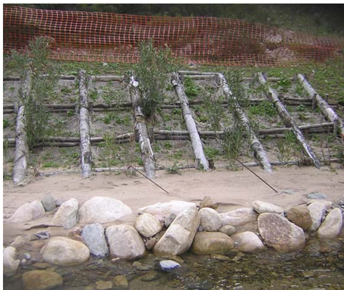
Il sito A, dopo la piena del 30 gennaio 2006: accumulo di materiale fino nella parte a monte (a sinistra) ed erosione al piede della grata nella parte a valle.
