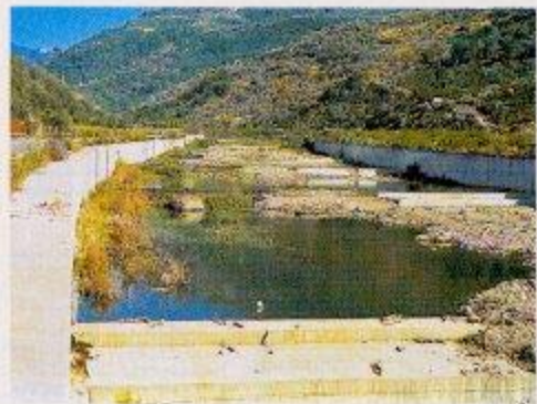
Monti Nebrodi (Sicilia): briglie e muri d'argine nella fiumara di Naso (tratto da: "I Nebrodi, lo stato dell'ambiente", Lega per l'Ambiente, Capo d'Orlando 1990)
