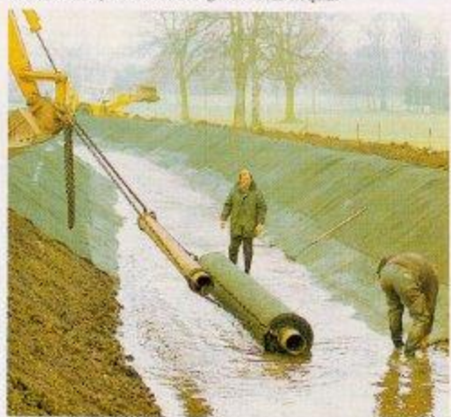
Posa in opera della stuoia tridimensionale di nylon Enkamat
