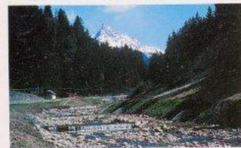
Rio Pala, Val d'Ega (1982), appena dopo la costruzione di coperture diffuse con salice come consolidamento di scarpate (foto Florin Florineth)
