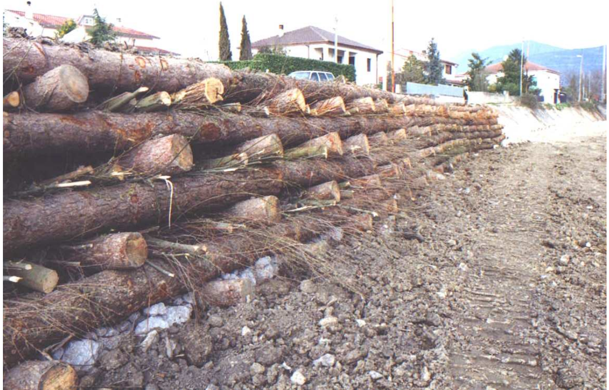
Figura 2: un esempio di buona esecuzione di una nuova palificata (Rio Inferno). Punti positivi sono l'abbondanza di talee di salice, anche di grandi dimensioni ed inserite in fase di costruzione, il diametro ragguardevole dei tronchi e l'inclinazione del paramento esterno. Foto marzo 2000.
