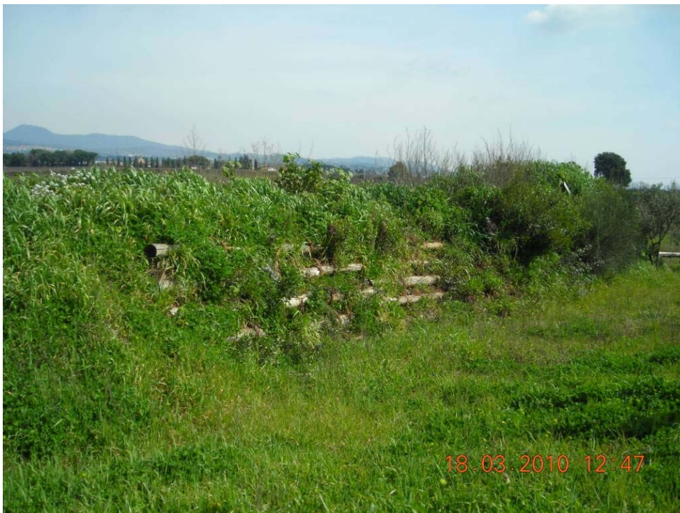
Figura 10. Palificata viva latina, campo sperimentale 2010 Albano Laziale.(JemmBuild s.r.l.)
