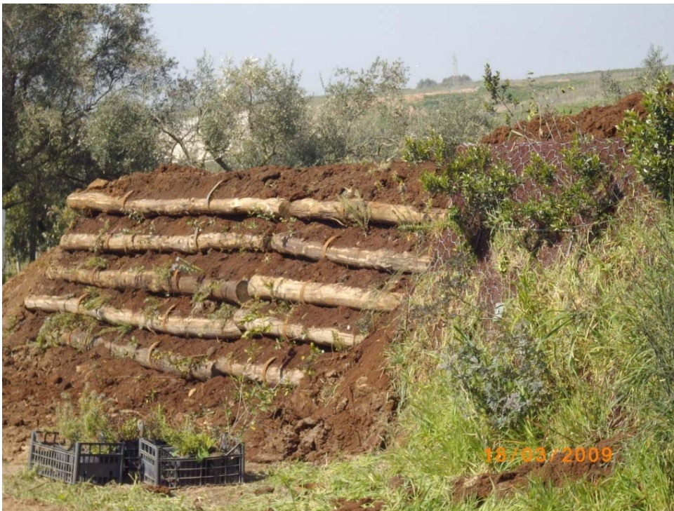
Figura 19. Rinverdimento dell'opera. (JemmBuild s.r.l.)
