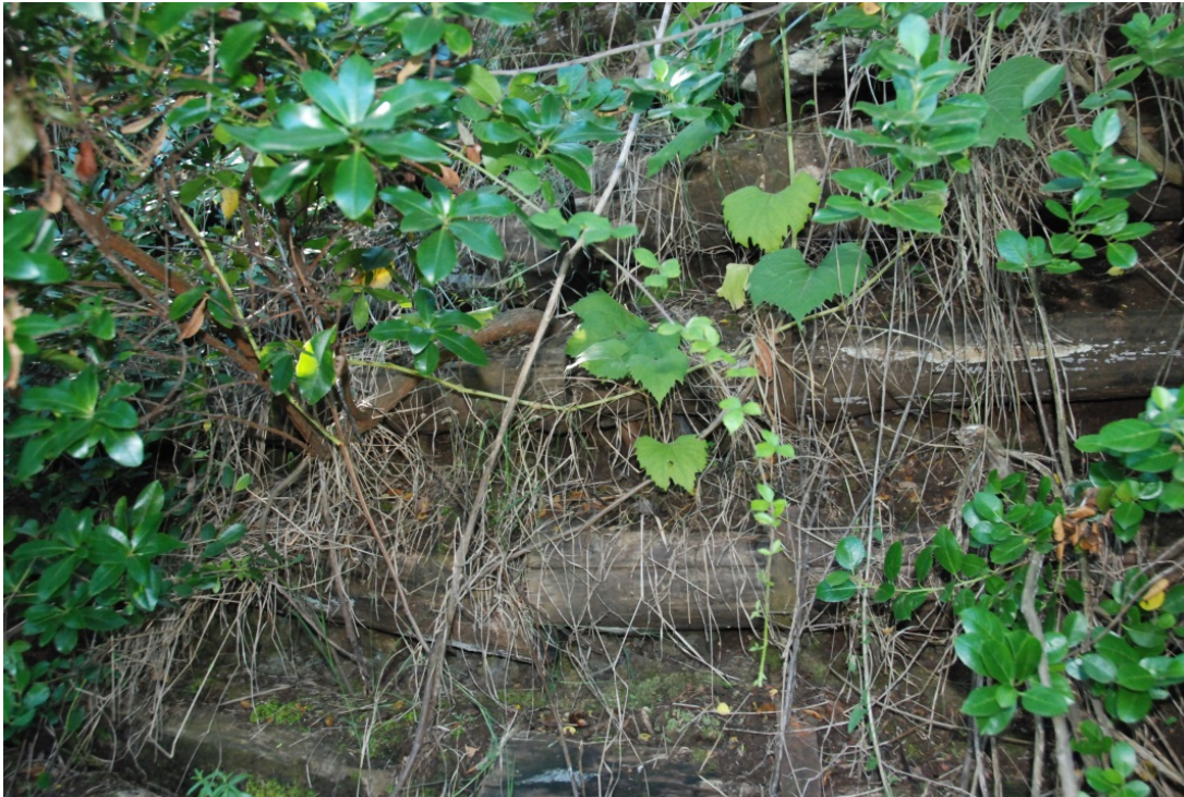
Figura 28. Copertura del 90 %, struttura in legno ancora visibile. (Camilla Linari)
