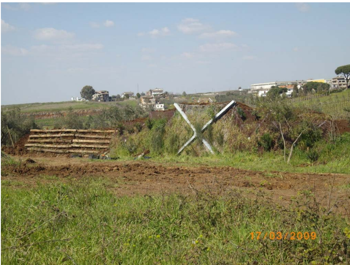
Figura 22. Prototipo loricata e struttura a monoancoraggio rinverdita nel 2009. (JemmBuild s.r.l.)
