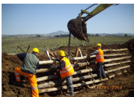
Figura 18 (a,b,c,d). Preparazione del terreno e ancoraggio della struttura in acciaio.(JemmBuild s.r.l.)
