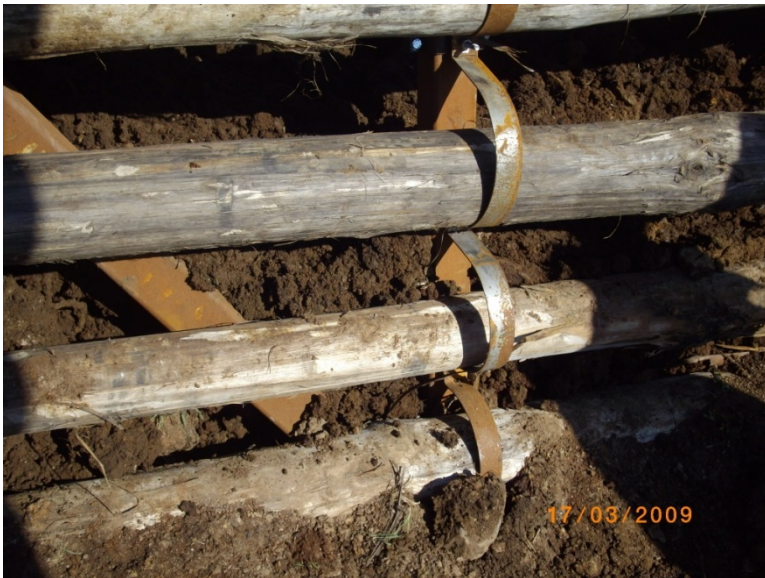
Figura 13. Collegamenti in acciaio.(JemmBuild s.r.l.)
