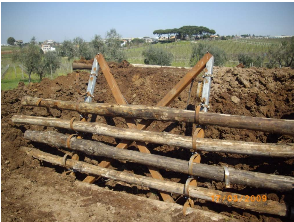
Figura 12. Struttura in legno della Loricata, campo sperimentale 2009 Albano Laziale. (JemmBuild s.r.l.)
