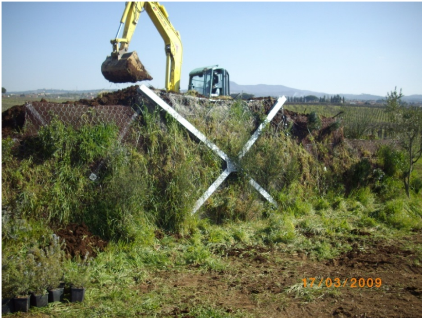
Figura 21. Strutture a monoancoraggio rinverdite. (JemmBuil s.r.l.)
