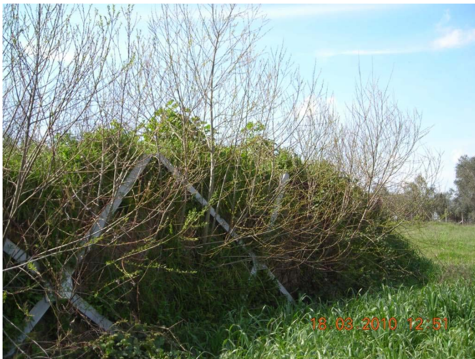
Figura 24. Struttura rinverdita versante sud 2010. (JemmBuild s.r.l.)
