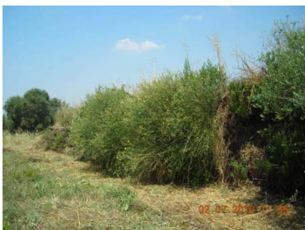
Figura 25. Loricata versante sud 2010. (JemmBuild s.r.l.)
