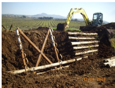
Figura 18 (a,b,c,d). Preparazione del terreno e ancoraggio della struttura in acciaio.(JemmBuild s.r.l.)
