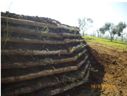
Figura 20. Riempimento della struttura. (JemmBuild s.r.l.)
