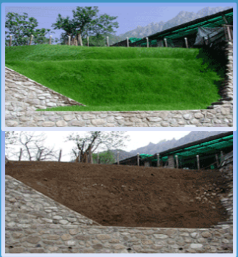
Idroseminatrice su scarpata (aprile 2002) Atina (FR) - Foto P. Cornelini
