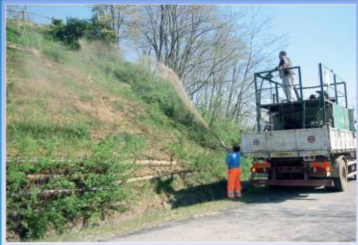
Idroseminatrice su scarpata (aprile 2002) Atina (FR) - Foto P. Cornelini
