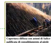
Copertura diffusa con astoni di Salice e palificata di consolidamento al piede dopo un anno
