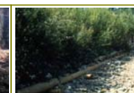
Copertura diffusa con astoni di Salice e palificata di consolidamento al piede dopo un anno
