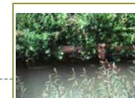
Palificata spondale con palo frontale verticale
