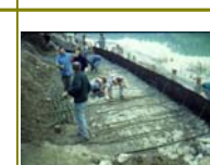
Terra rinforzata spondale in rete metallica e stuoia sintetica con astoni di Salice
