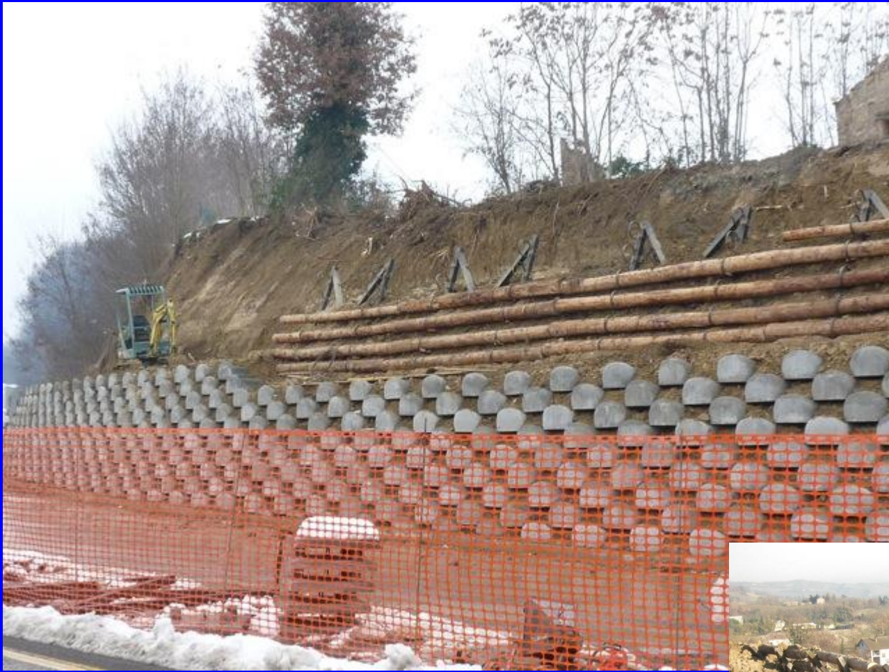
Lavori in corso 2011 (Foto Marrone)
