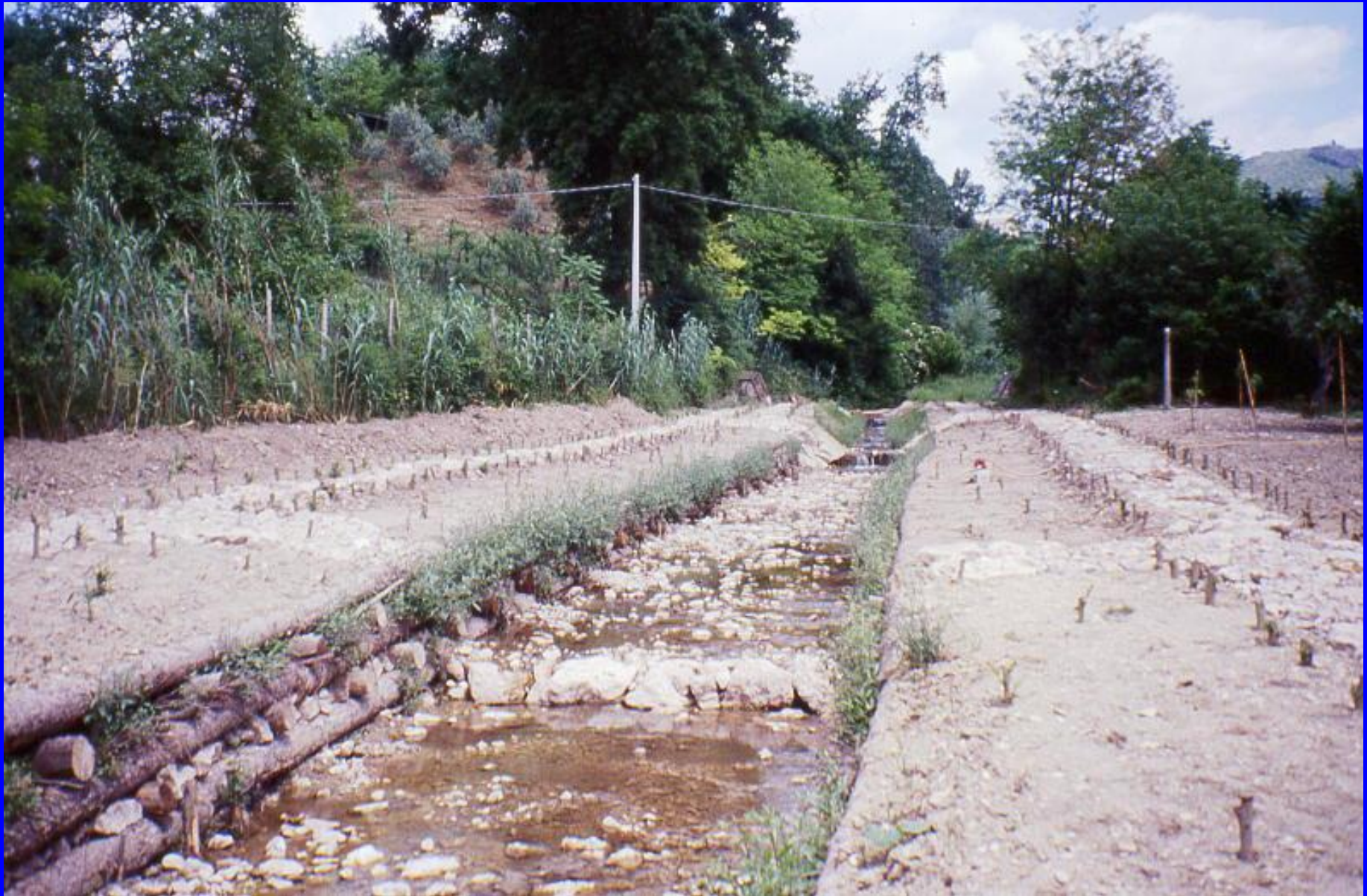
Rio Inferno - Cassino (FR) maggio 2000 primo intervento di sistemazione idraulica nel Lazio: palificate vive spondali
