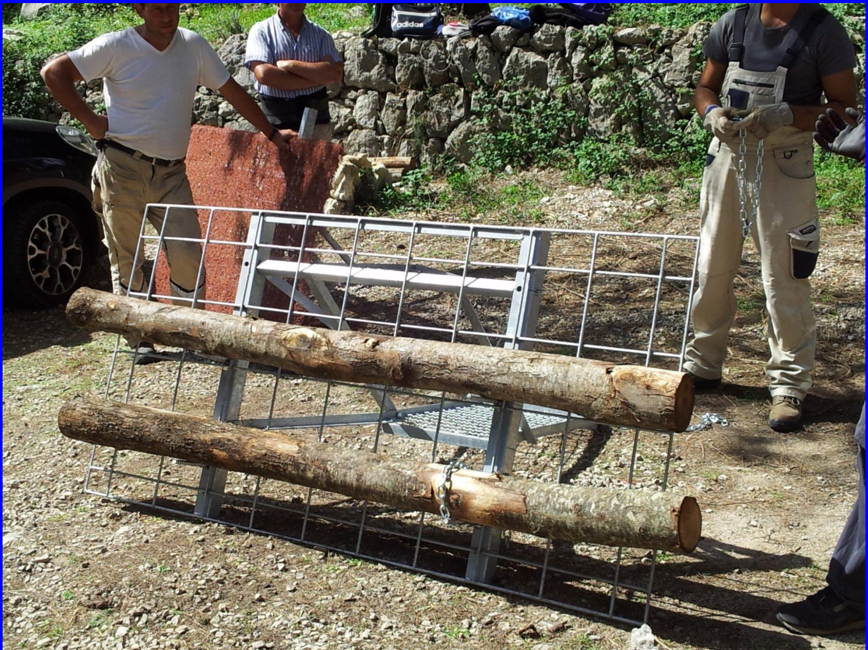
Dimostrazione montaggio palificata loricata - Cantiere didattico del Corso di Ingegneria Naturalistica presso l'Istituto Costruzioni, Ambiente, Territorio "Bruno Tallini" di Formia (LT)
