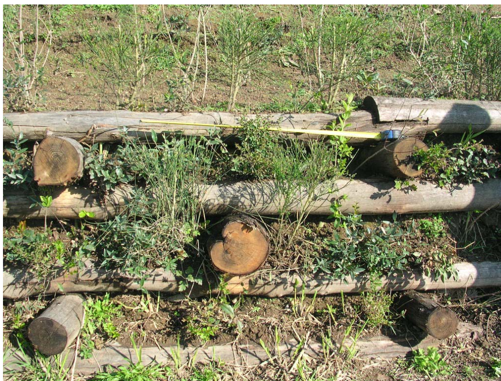
Foto 31 - Palificata viva di sostegno
