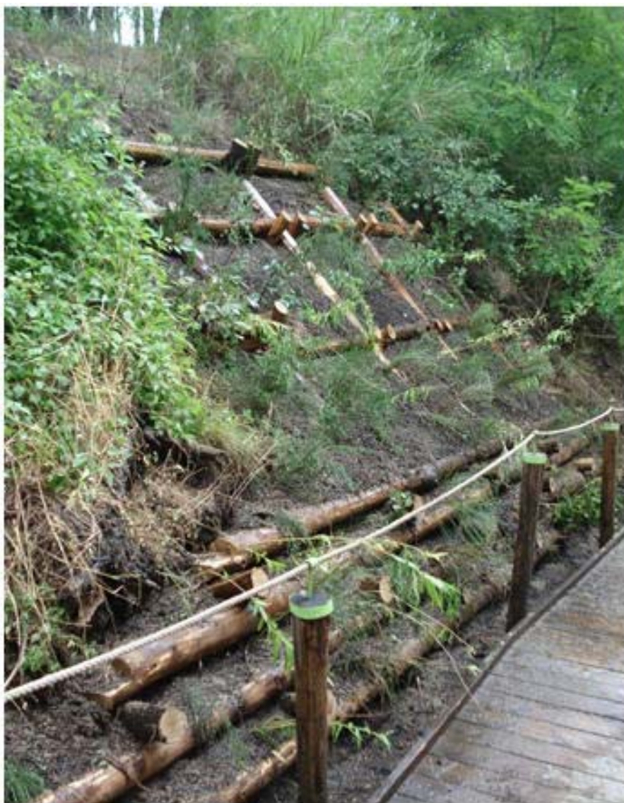
Foto 14 - Particolare della disposizione degli elementi orizzontali nella grata Vesuvio - Terzigno (NA).
