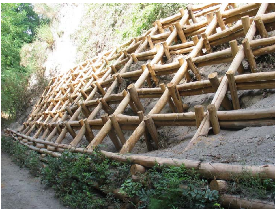
Foto 11 e 12 - Esempi di Grata Vesuvio in fase di esecuzione.
