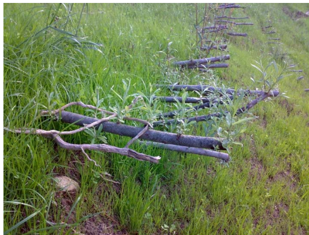
Foto 9 - Gradonate vive di sostegno - Chiesa Ss. Protomartiri - Roma (RM) - 2010.
