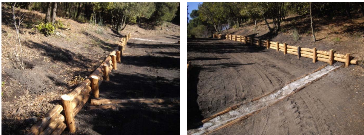
Foto 5 - Esempi di palizzate in legno. Opera eseguita nella Riserva Tirone Alto Vesuvio nell'ambito del progetto FORCLIMADAPT, nel Parco Nazionale del Vesuvio sito MAB UNESCO (NA).
