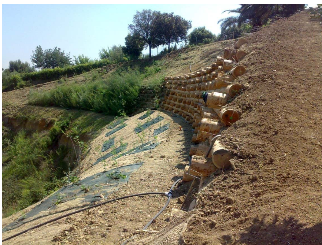
Foto 18 - Palificata viva di sostegno a parete doppia - a lavorazione ultimata - Roma Ss. Protomartiri - 2011.
