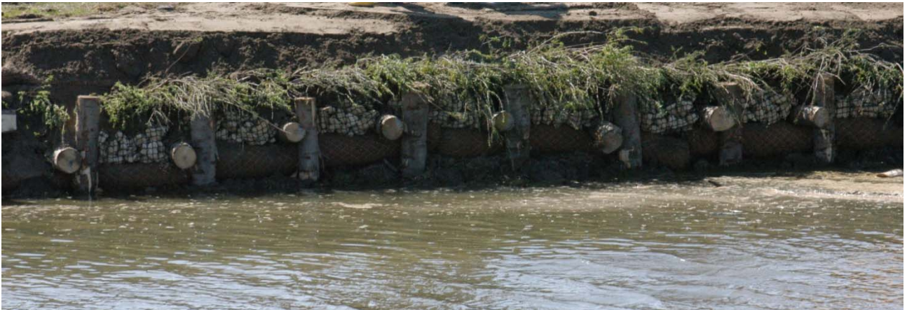
Foto 32 - Palificata spondale viva - Località Ca' Vendramin (RO).
