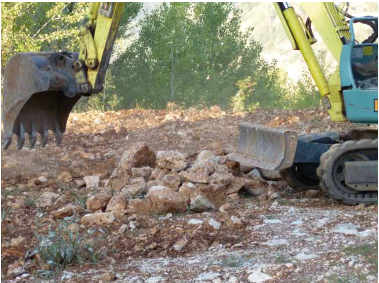
Figura S2 Preparazione del substrato mediante rimozione di massi e blocchi rocciosi dal terreno di riporto. Foto F. Gilardelli
