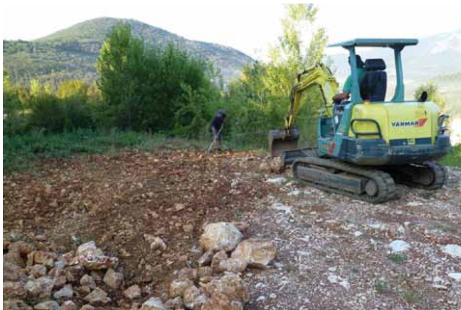
Fig. 26 Lavorazione del substrato ed asportazione dei massi con dimensioni superiori a circa 50 cm tramite macchine operatrici leggere e a mano (ATE o13). Foto: F. Gilardelli
