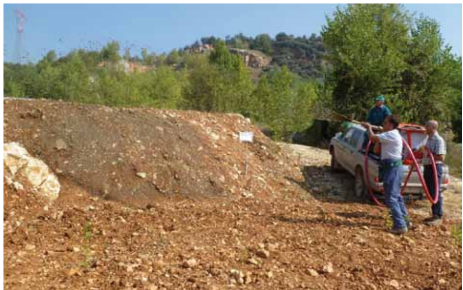
Fig. 33 Idrosemina di sementi commerciali (ATE o13). Foto: F. Gilardelli
