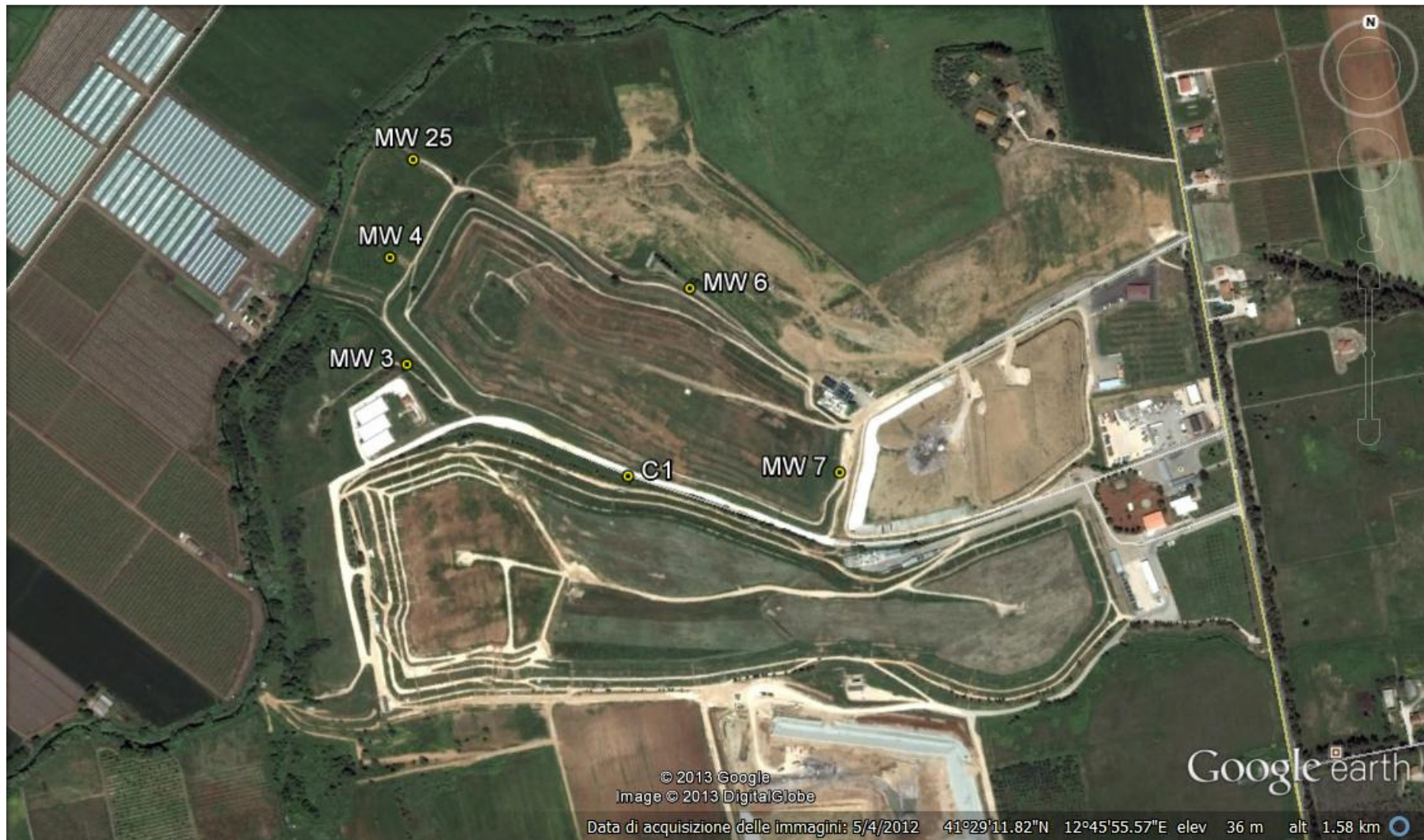
Fig.2: ubicazione dei piezometri adibiti al monitoraggio dei bacini di discarica in fase di gestione post operativa
