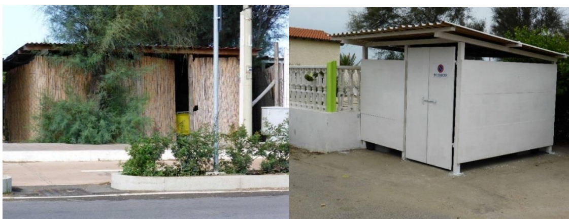
Figura 30- Esempi di Ecobox degli stabilimenti balneari a Fiumicino
