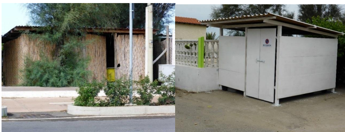
Figura 108– Esempi di Ecobox degli stabilimenti balneari a Fiumicino
