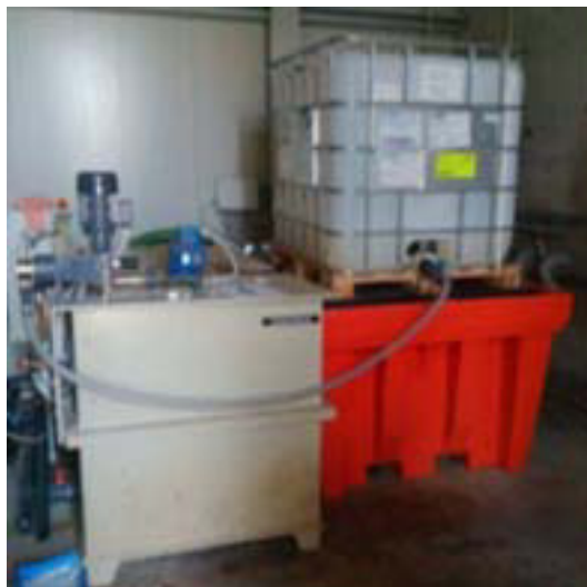
Figura 33 – Sistema di preparazione del poli-elettrolita previsto per l'installazione
